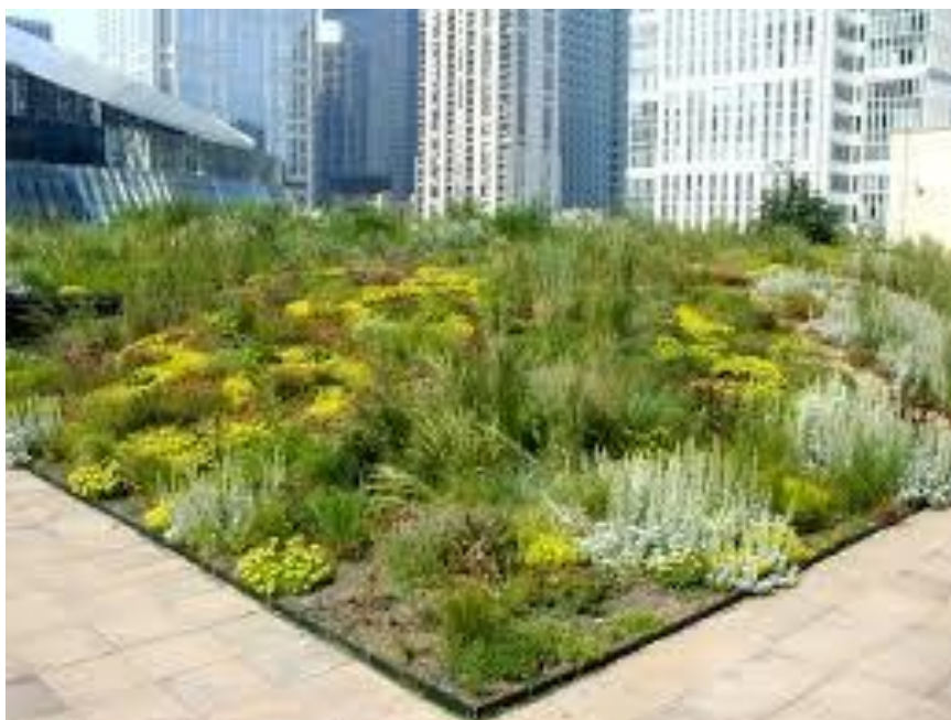
Εικόνα 2: Φυτοδώμα ημιεντατικού τύπου (πηγή: http://www.greenroofs.com )
