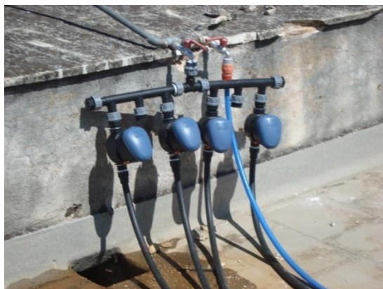
Εικόνα 19: Η παροχή νερού (βρύση της ταράτσας) και οι 2 ηλεκτροβάνες για τις διαφορετικές συχνότητες άρδευσης.
