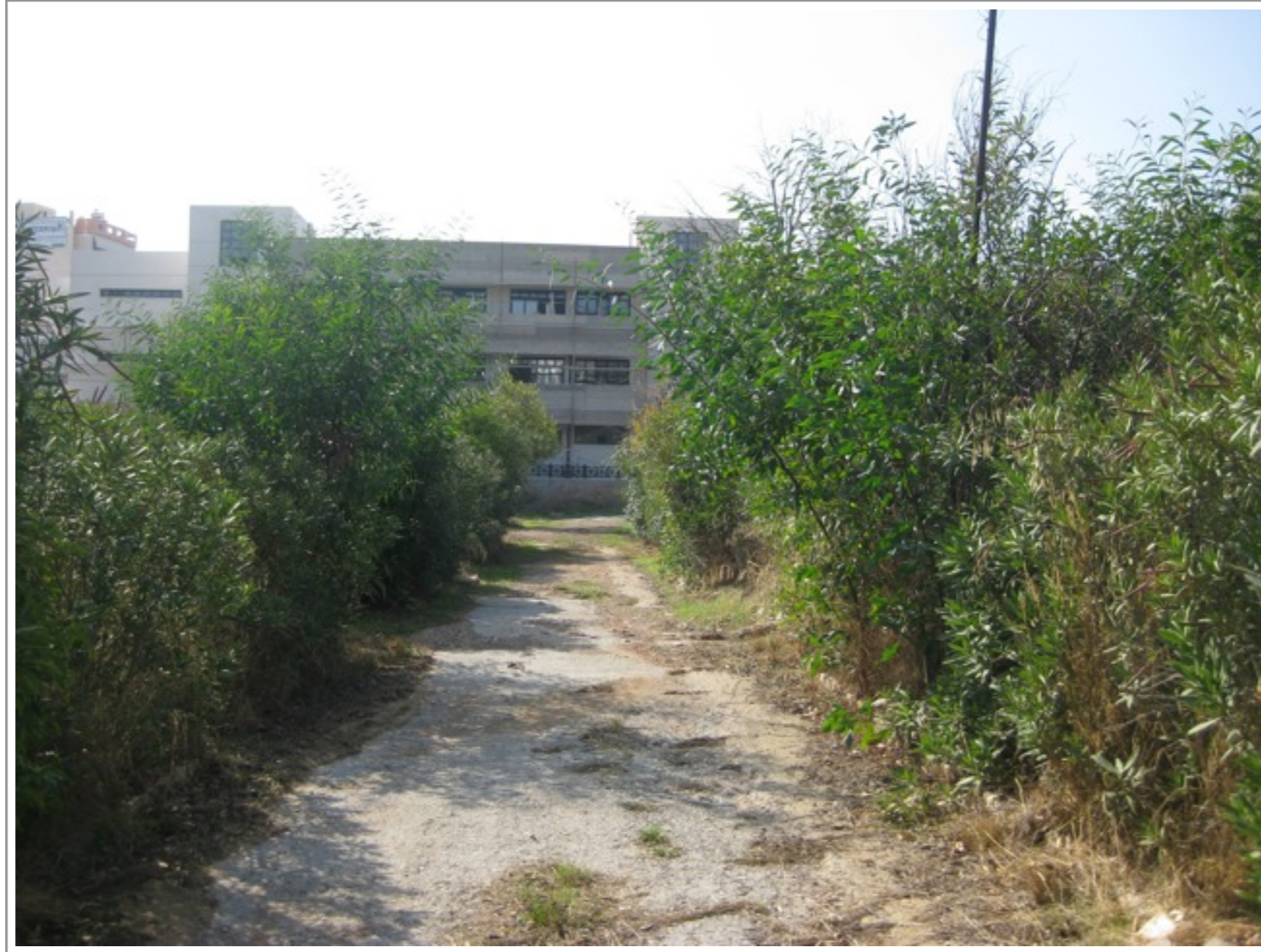
ΕΙΚΟΝΑ 34. ΣΧΟΛΙΚΟ ΚΤΙΡΙΟ ΑΠΟ ΤΟ ΕΣΩΤΕΡΙΚΟ ΤΟΥ ΠΡΩΗΝ ΚΟΙΜΗΤΗΡΙΟΥ
