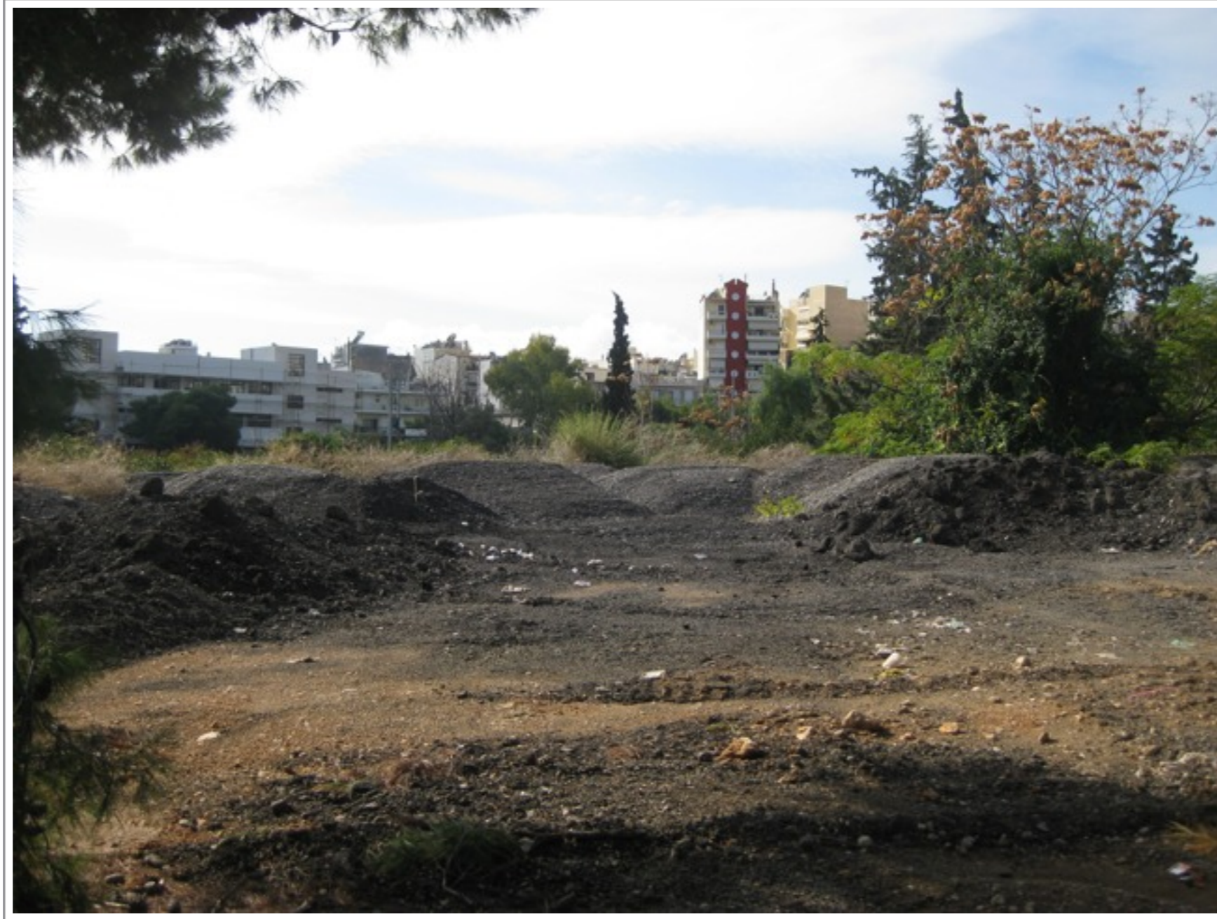
ΕΙΚΟΝΑ 32. ΥΛΙΚΑ ΑΣΦΑΛΤΟΣΤΡΩΣΗΣ ΕΝΤΟΣ ΤΟΥ ΧΩΡΟΥ
