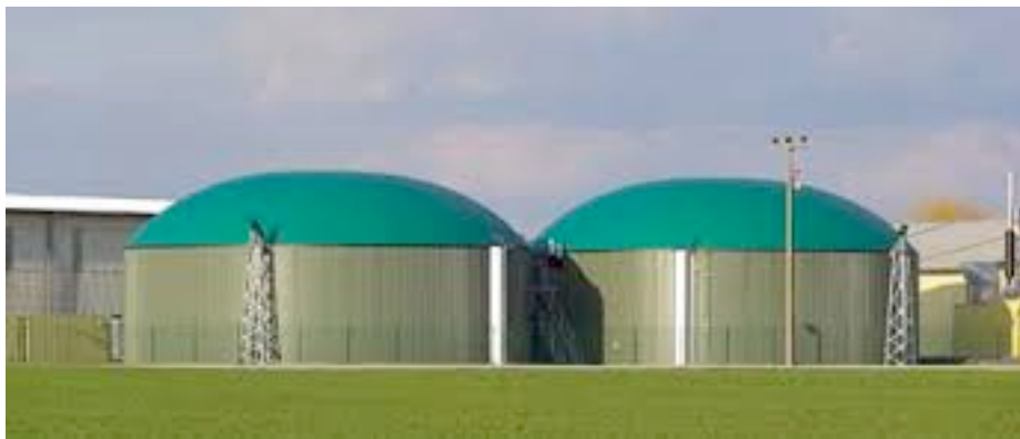
Εικόνα 2.2.2. Τυποί αναερόβιου χωνευτήρα
