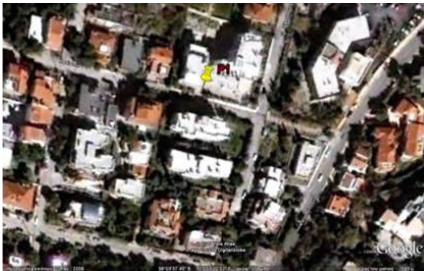
Εικ. 8 : Σημείο P1 στην οδό Ηφαιστου (Δομημένη Περιοχή), από αέρος άποψη (GoogleEarth)
