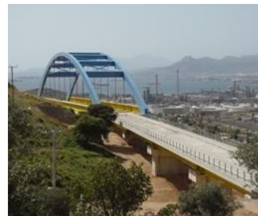
Εικ.58: Τα νέα σιδηροδρομικά έργα που βρίσκονται σε εξέλιξη (Θριάσιο Πεδίο πάνω και γραμμή Ν. Ικονίου – Θριασίου κάτω) (Πηγή: www.ergose.gr )
