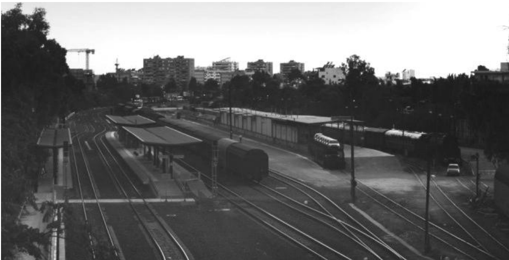
Εικ.74: Απόψεις του Σιδηροδρομικού Σταθμού (Πηγή: www.panoramio.com )
