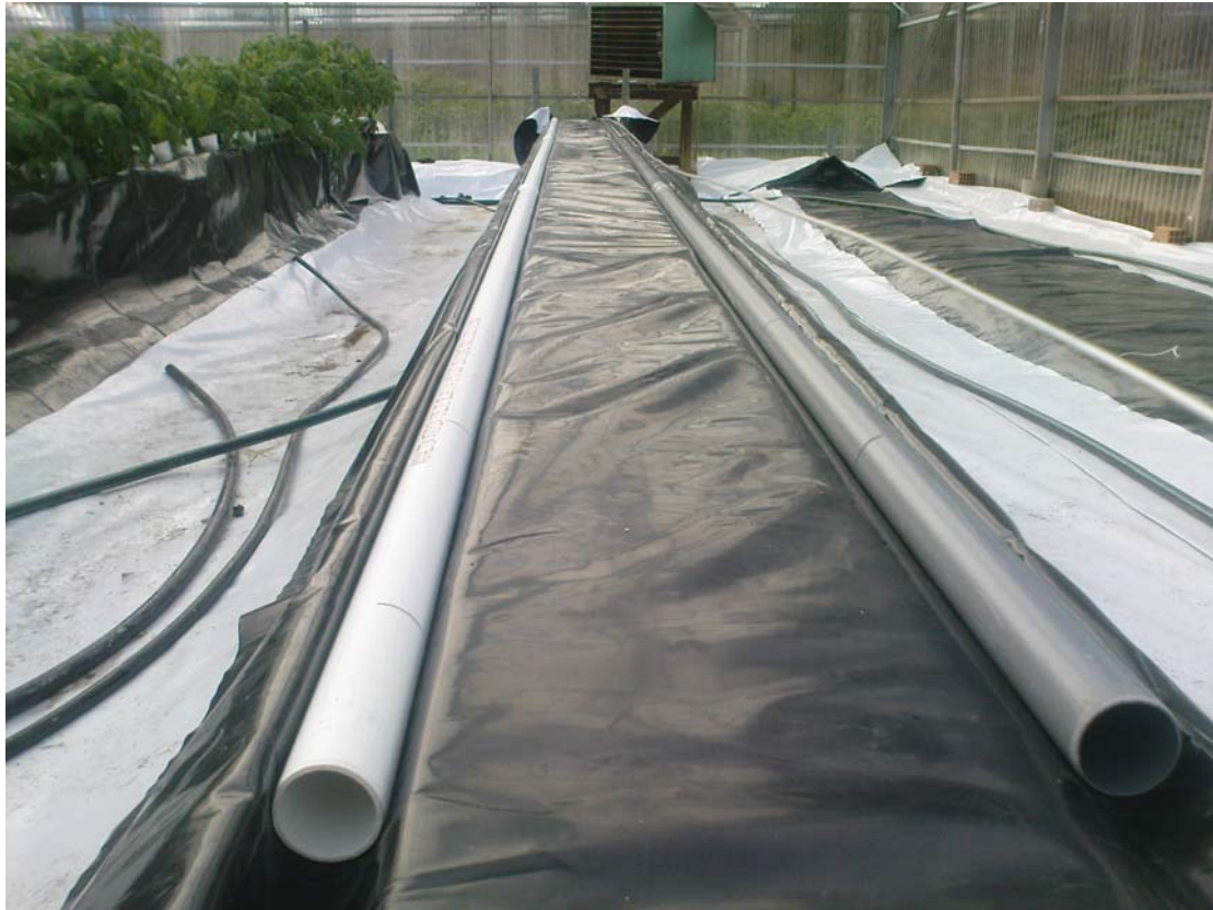
Εικόνα 2. Κατασκευαστική λεπτομέρεια σωλήνων απορροής και στράγγισης.
