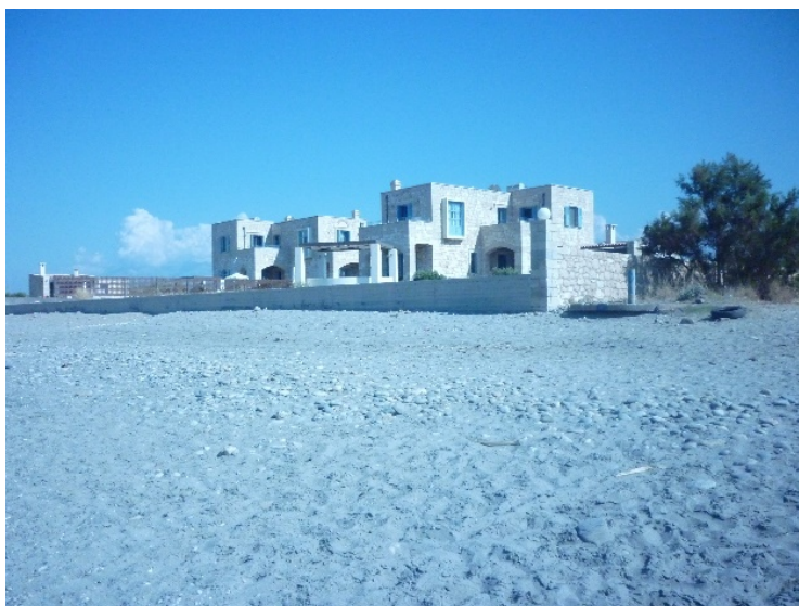
Εικόνα 3.2: Κτίσμα πάνω στην αμμόδης παραλία
