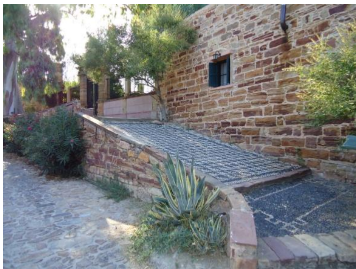
Εικ 60. Βοτσαλωτή ράμπα με πεζούλες έξω από την αυλόπορτα του κτήματος Καράβα στον Κοκκαλά ποταμό (προσωπικό αρχείο)
