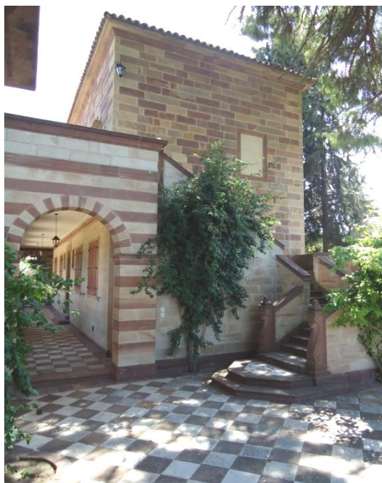
Εικ 215. Το νέο σπίτι των Αργέντιδων μετα τον σεισμό του 1881. (προσωπικό αρχείο)
