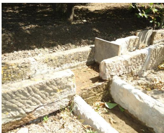
Εικ176.,177. Ξύλινες σανίδες τοποθετούνται σε επιλεγμένα σημεία στα πέτρινα κανάλια για να καθορίσουν την επιθυμητή πορεία του νερού.(προσωπικό αρχείο)
