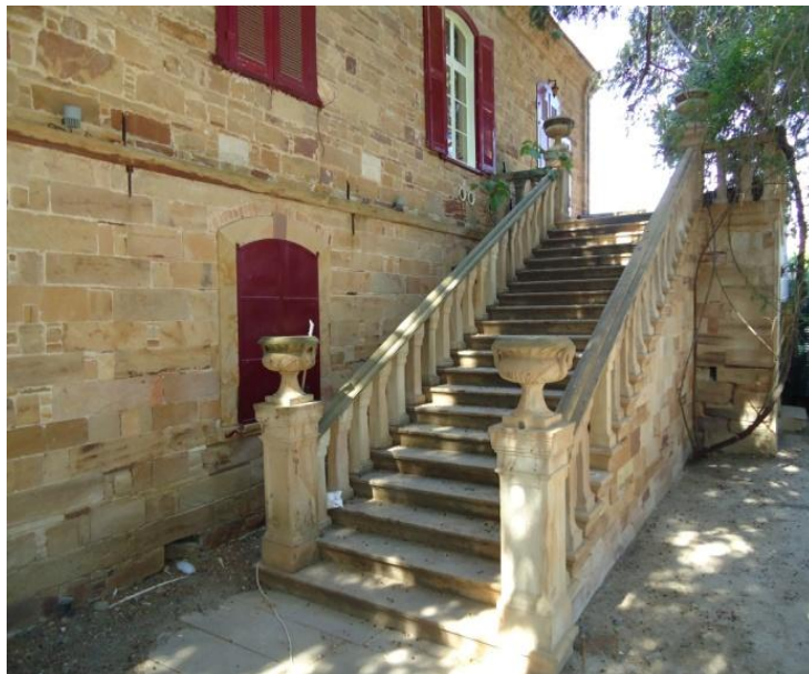
Εικ 201. Η πέτρινη σκάλα του αρχοντικού Καράλη. Η σκάλα καταλήγει στον αυλόγυρο ακριβώς δίπλα από την αυλόπορτα. Πύλινα φυτόδοχεία διακοσμούν την σκάλα στο επίπεδο του πρώτου και του τελευταίου σκαλοπατιού. (προσωπικό αρχείο)
