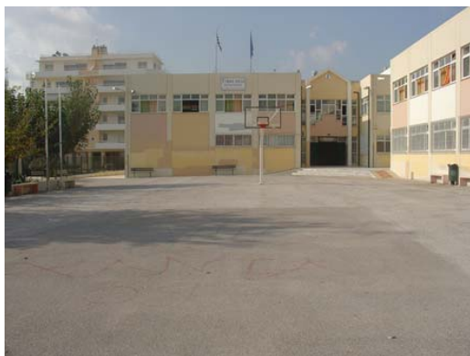
Εικόνα 36: Επίστρωση με τσιμέντο
