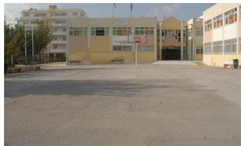
Εικόνα 27: Άποψη αυλής 9 ου Λυκείου
