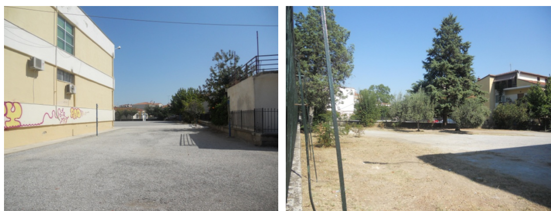
Εικόνα 10β) Άποψη της πλαϊνής όψης του σχολείου. Διακρίνεται στο βάθος συστάδα δένδρων.
