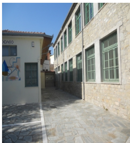
Εικόνα 4γ) Άποψη του προαύλιου
