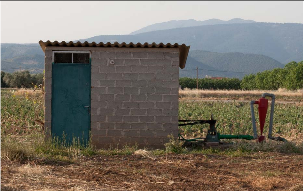
Σύγχρονη γεώτρηση εντός του πηγαδιού με κωνικό φίλτρο για το εφαρμογή λίπανσης
