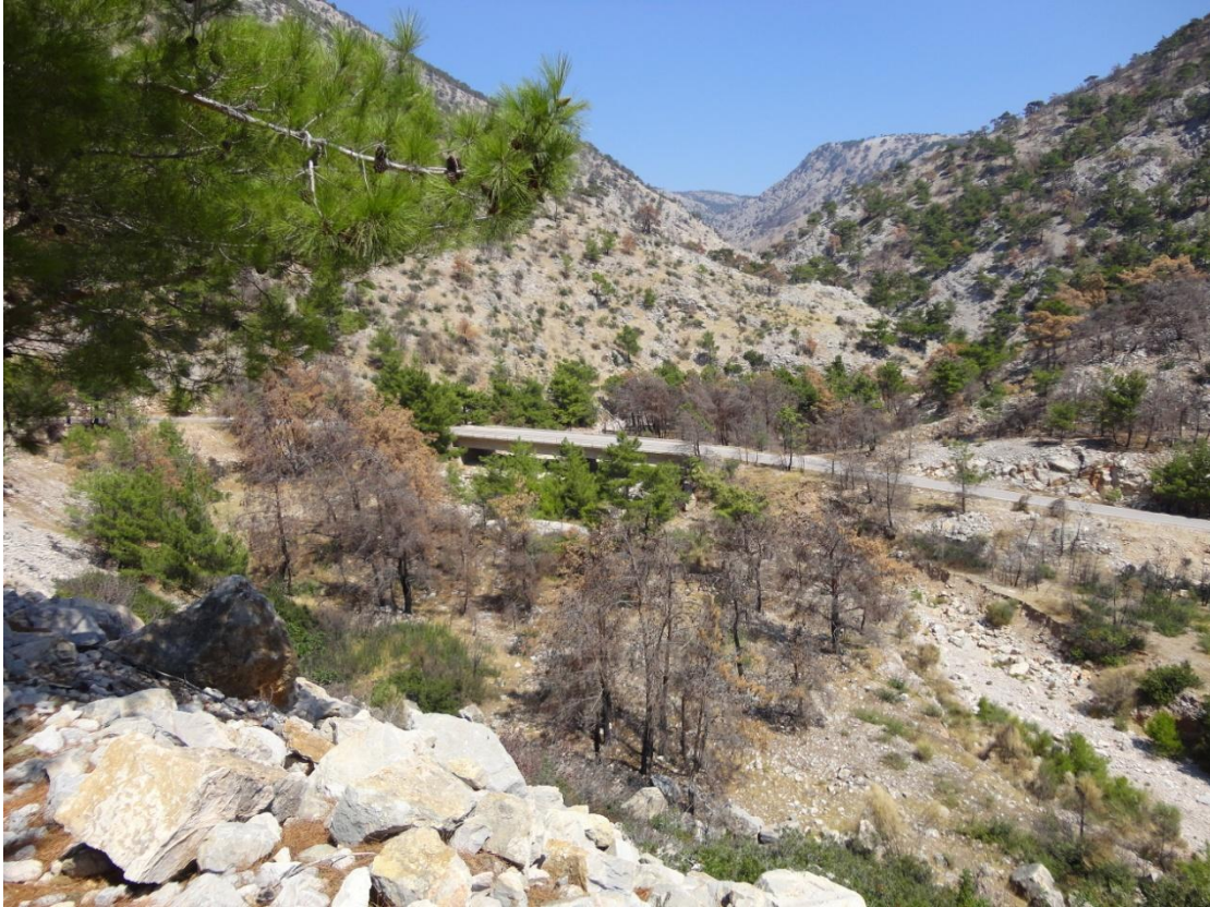
Εικόνα 72. Σημείο 34 (Βόρεια διεύθυνση)
