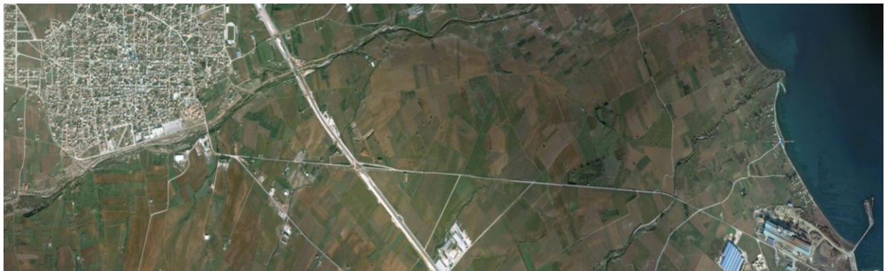
Εικόνα XII.4.:το οδικό δίκτυο της περιοχής έρευνας, η ΠΑΘΕ, τμήμα της επαρχιακής οδού. Διακρίνεται επίσης το άρτιο σχήμα των αγρών που οφείλεται στο πυκνό και εκτεταμένο δίκτυο από χωματόδρομους και σκυρόστρωτους δρόμους, ενδιάμεσα των αγρών. (Εικόνα Google earth)
