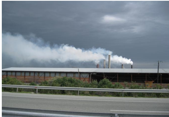
Εικόνα XIII.8: Έκλυση ρύπων από εργοστάσιο στη ΒΙ.ΠΕ. Αλμυρού, (Αρχείο Χουλιάρης Γ. 2013).
