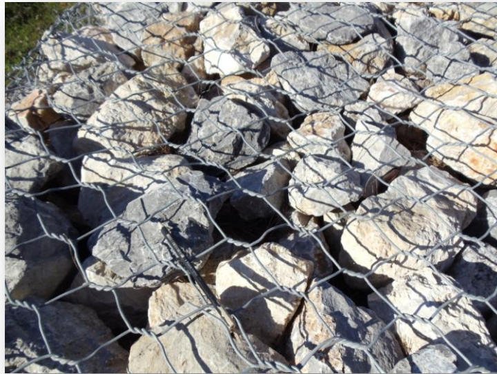
Σχήμα 17: Ασβεστολιθικό υλικό πλήρωσης των συρματοκιβωτίων ποικίλου μεγέθους τεμαχίων (φωτ. 4.1.2013).
