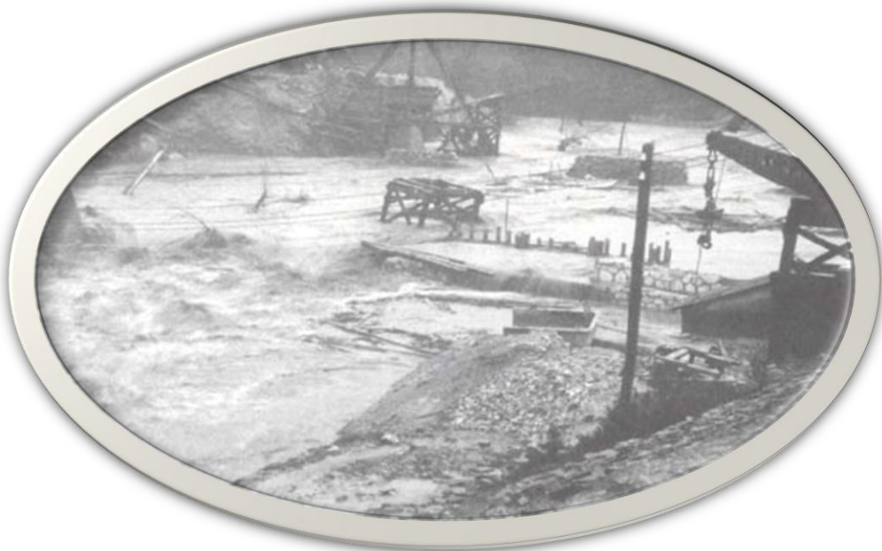
Σχήμα 71: Αστοχία φράγματος Μαραθώνα. Υπερπήδηση προφράγματος και κατάκλυση περιοχής θεμελίωσης φράγματος. (Φωτ.αρχείο ΕΥΔΑΠ).
