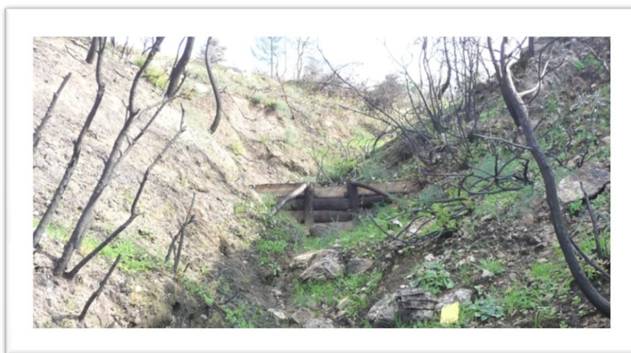
Σχήμα 8: Και η μέθοδος LDD χρησιμοποιείται κατά κόρον σε περιοχές οι οποίες έχουν πληγεί από φαινόμενα πυρκαγιάς και είναι αποτελεσματική στη συγκράτηση ιζημάτων καθώς και στην ελάττωση της ταχύτητας του επιφανειακού νερού. Στη φωτογραφία το φράγμα κατασκευάστηκε στον Μαραθώνα μετά την πυρκαγιά του 2009 (φωτ. αρχείο Ι. Παπανικολάου).
