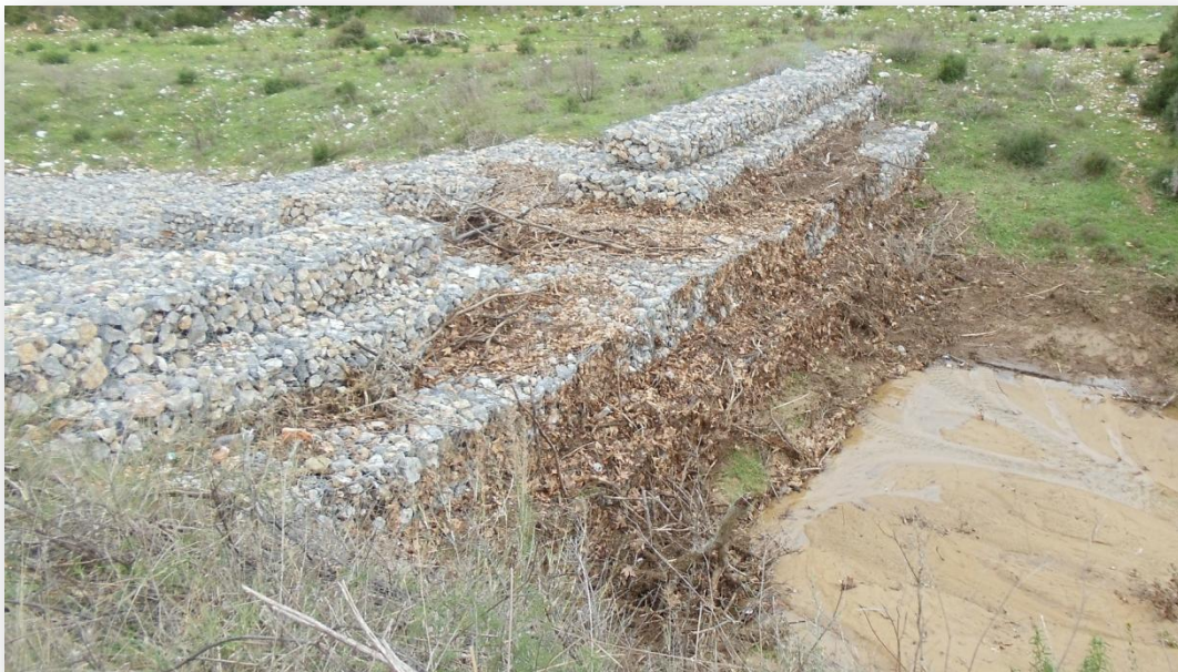
Σχήμα 9: Αντιδιαβρωτικό φράγμα με κιβώτια συρματοπλέγματος στη λεκάνη του Μαραθώνα, εγκάρσια στην κοίτη του ποταμού Σπαρτόρρεμα (φωτ. 27/1/2013).
