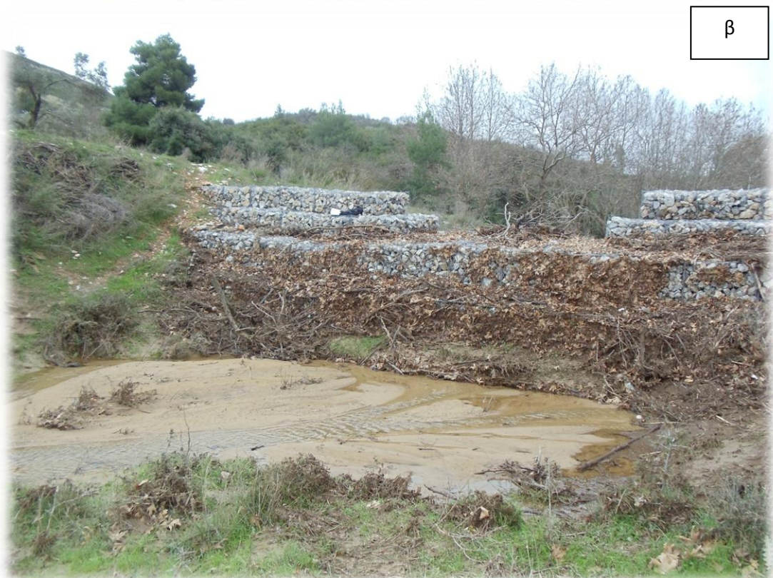
Σχήμα 22: α) φωτογραφία του 2009 με το πρώτο πλημμυρικό γεγονός της μεταπυρικής περιόδου του 2009 (φωτ. αρχείο Ι. Παπανικολάου) στην οποία δεν υπάρχει σημαντική ποσότητα υλικού και β) Άποψη του φράγματος τον Ιανουάριο του 2013, με σημαντική αύξηση του αποτιθέμενου υλικού.
