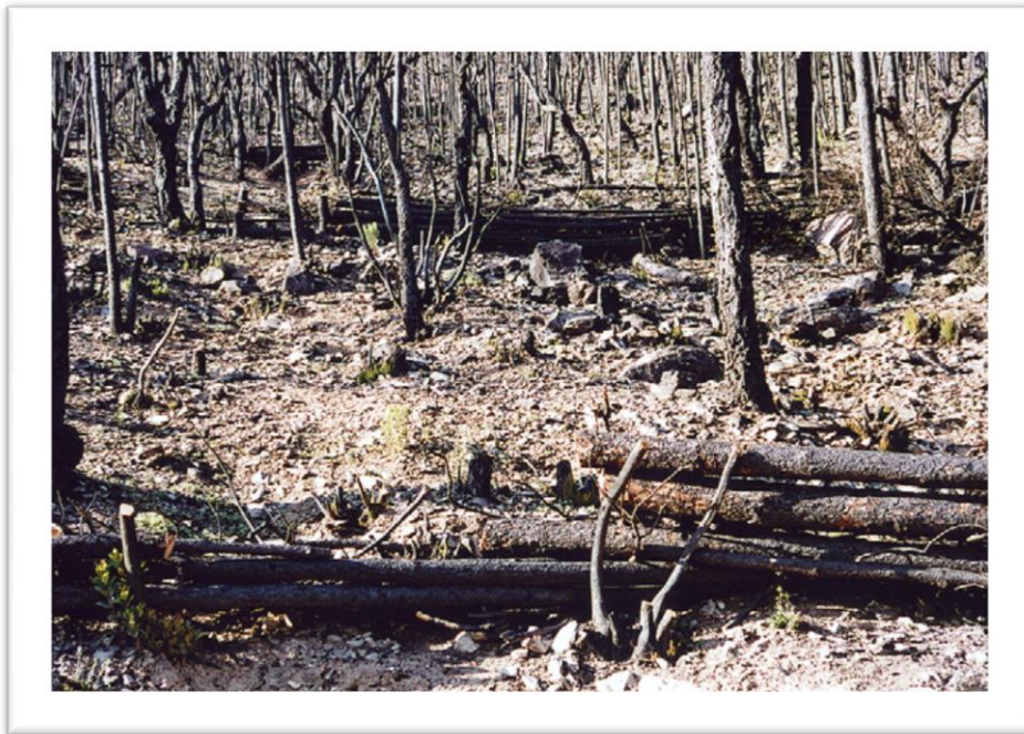
Σχήμα 7: Η μέθοδος LEB (Fox 2011) χρησιμοποιείται για τη μείωση του ρυθμού διάβρωσης και τη διασπορά του διαθέσιμου εδαφικού υλικού.
