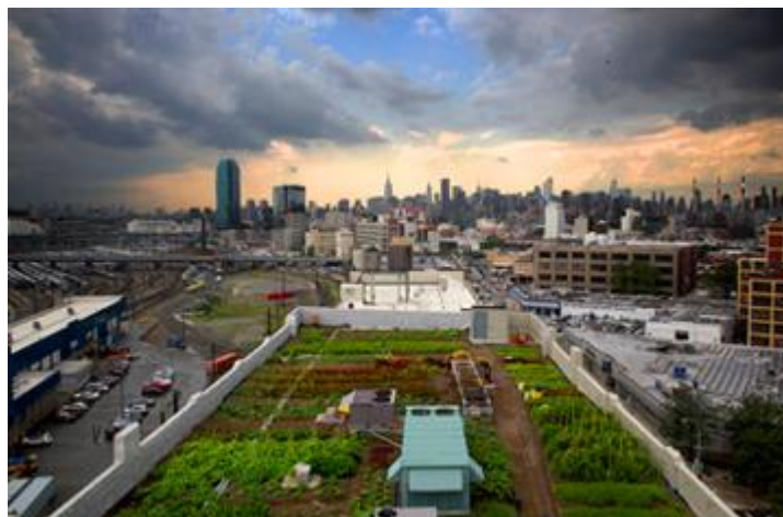
Εικόνα 23: Ο εμπορικός ταρατσόκηπος στην οροφή του κτιρίου της εταιρείας Brooklyn Grange στην περιοχή Queens, New York. (Πηγή: Δ18)
