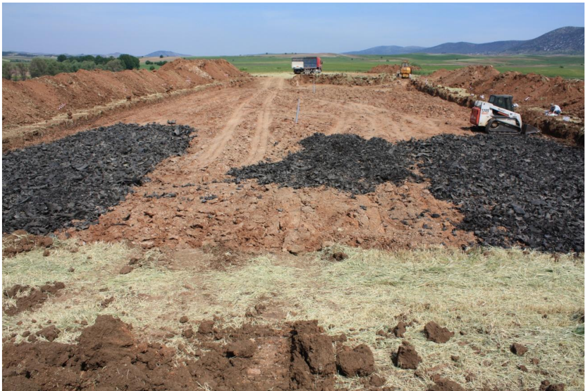
Εικόνα 10: Η διάσπρωση των τεμαχισμένων ελαστικών για τη δημιουργία της στρώσης 20cm.
