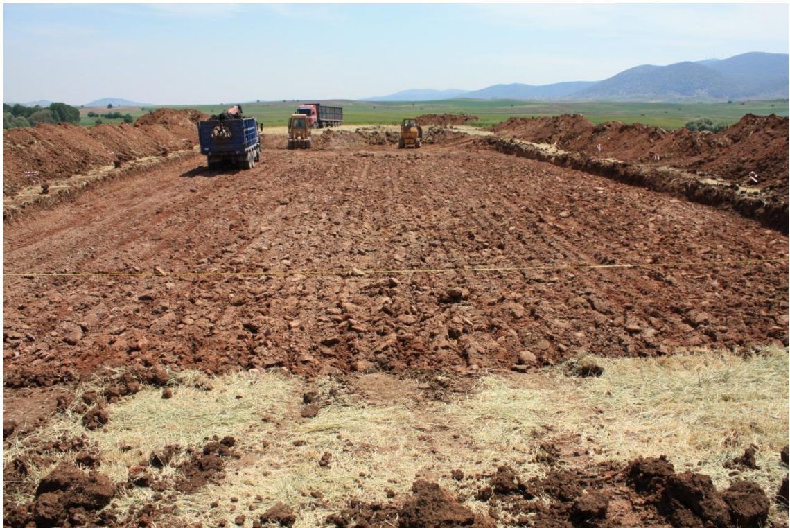
Εικόνα 7: Στο κατεργασμένο έδαφος πραγματοποιήθηκε η 1 η δειγματοληψία εδάφους πριν τη στρώση των τεμαχισμένων ελαστικών.
