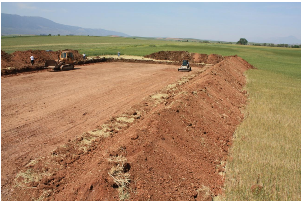
Εικόνα 5: Εκσκαφή της έκτασης της έρευνας για τη στρώση τεμαχισμένων ελαστικών σε καλλιέργεια σιταριού.
