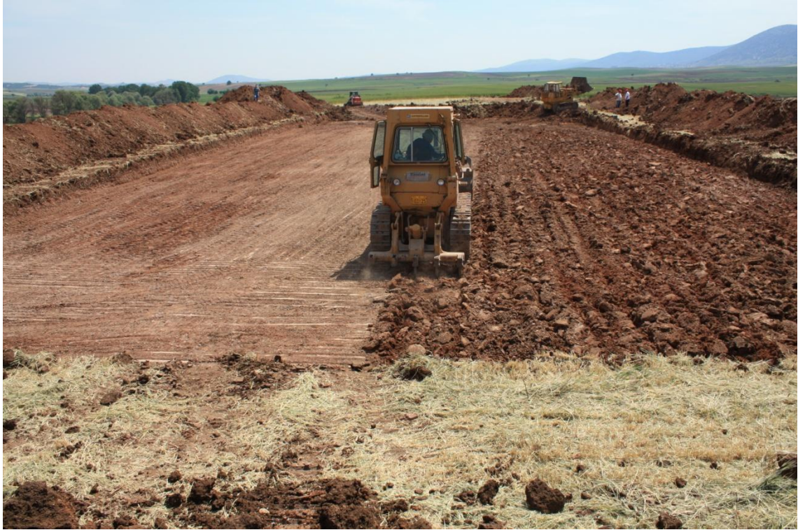
Εικόνα 6: Η κατεργασία στο σκαμμένο έδαφος για τυχόν συμπίεση που προκάλεσαν τα μηχανήματα εκσκαφής.
