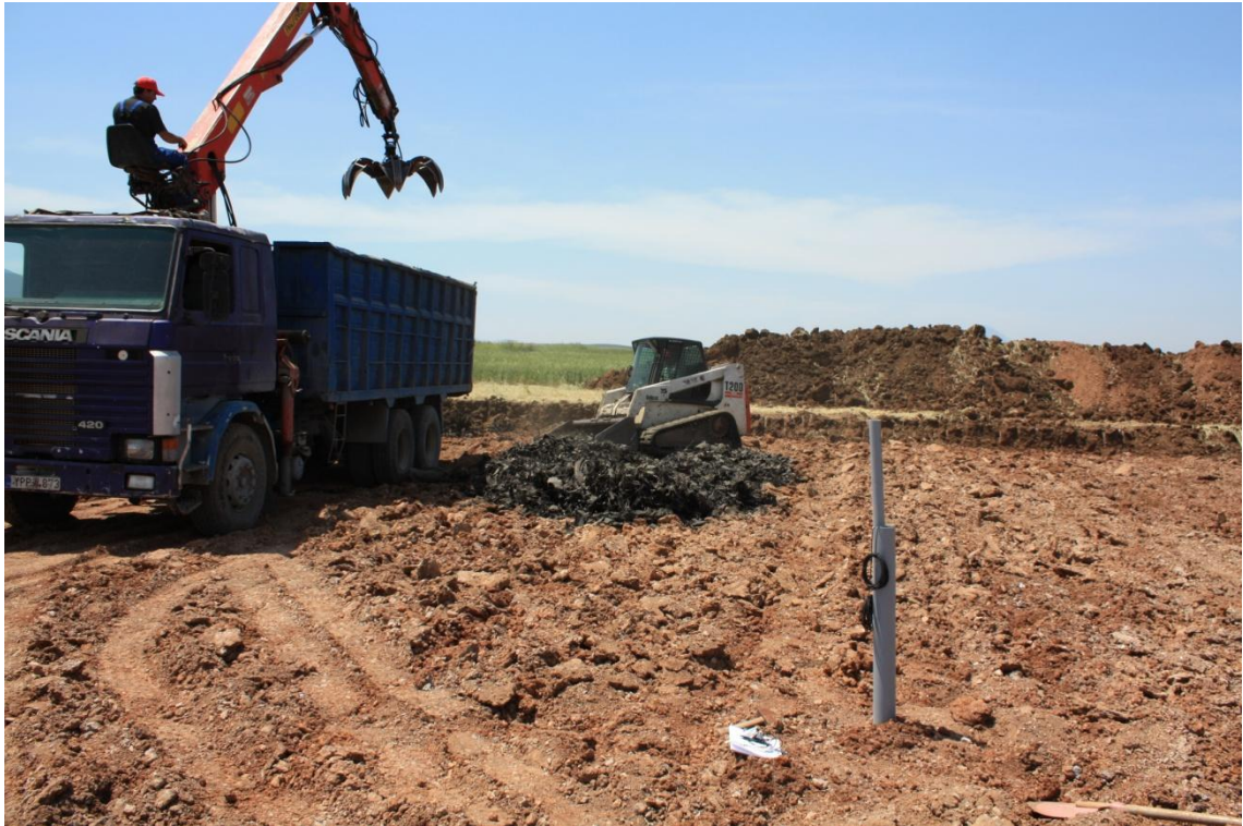
Εικόνα 9: Εγκατάσταση των αισθητήρων μέτρησης υγρασίας κάτω από τη στρώση των ελαστικών.
