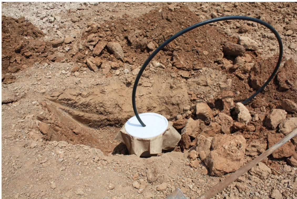
Εικόνα 8: Τοποθέτηση πλαστικού κουβά κάτω από τη στρώση των ελαστικών για τη συλλογή νερού και τον έλεγχο τυχόν επιπτώσεων από αυτά.
