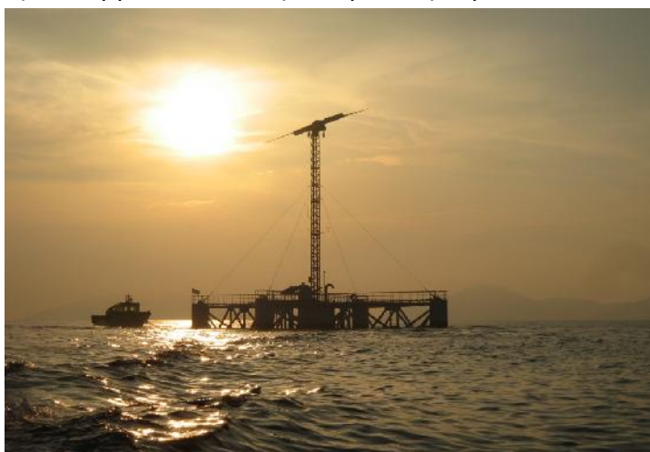
Εικόνα 6.3 Πλωτή μονάδα αφαλάτωσης, η οποία λειτουργεί με μία Α/Γ, είναι κατασκευασμένη από το Πανεπιστήμιο Αιγαίου. [95]
