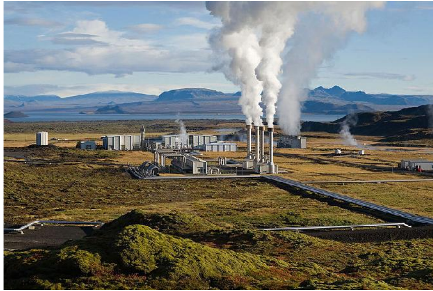
Εικόνα 3.5 Μονάδα αφαλάτωσης με γεωθερμία στο Nesjavellir της Ισλανδίας
