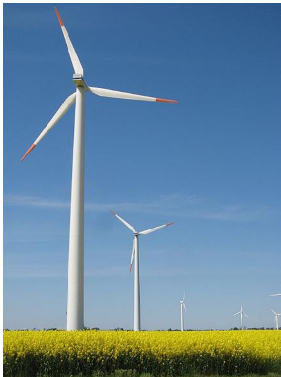
Εικόνα 3.4 Αιολικό πάρκο στο Χόλσταϊν της Γερμανίας ( www.wikipedia.com )
