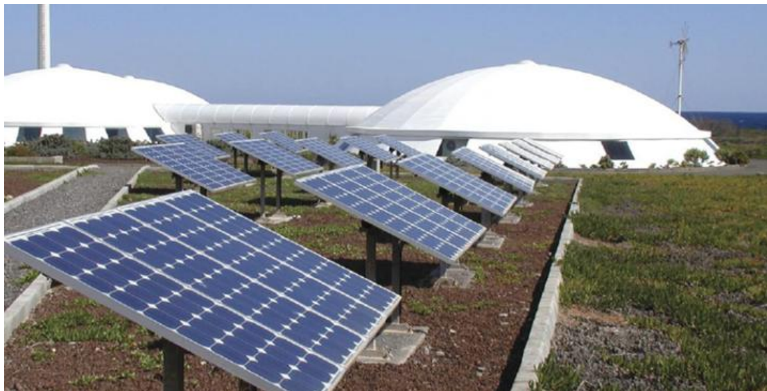
Εικόνα 4.4. Αυτόνομη Μονάδα Αφαλάτωσης Αντίστροφης όσμωσης στα Κανάρια Νησιά με φωτοβολταϊκά κελιά.
