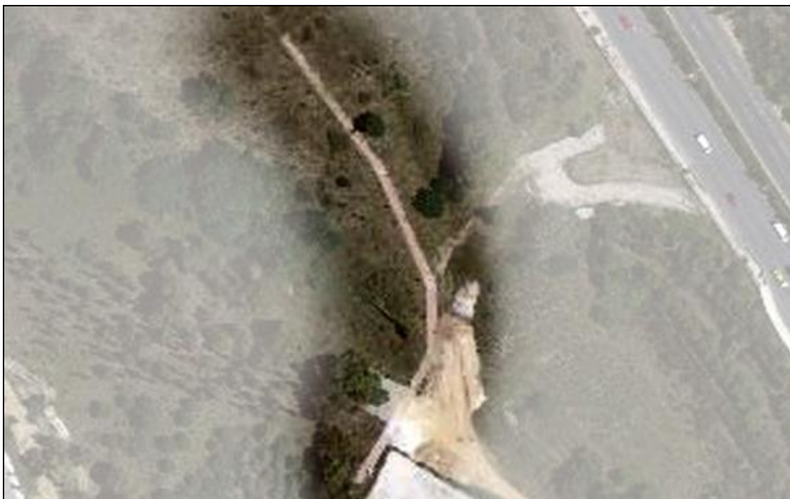
Εικόνα 5.25. Ο πεζόδρομος καταλήγει σε αδιαμόρφωτη υπαίθρια περιοχή.
