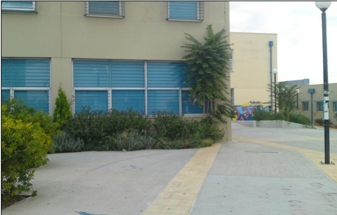
Εικόνα 5.58. Πολιτικοί Μηχανικοί. Μικρά κηπάρια, χωρίς επαρκή επιφάνεια και εδαφικό υπόστρωμα για ανάπτυξη δέντρων ή πολυόροφης βλάστησης. Έκθεση παραθύρων σε άμεση ηλιακή ακτινοβολία χωρίς βιοκλιματική ρύθμιση εποχή με τις κατάλληλες κατασκευές (στέγαστρα) ή φυτεύσεις (φυλλοβόλα)
