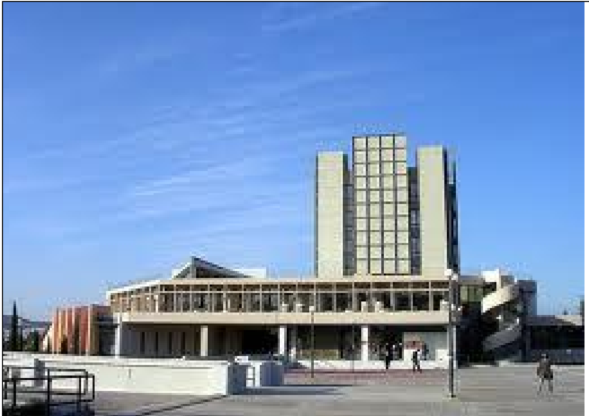
Εικ 3.2. Κτίριο Βιβλιοθήκης. Με τον ειδικό σχεδιασμό και το ύψος του, δίνει προσανατολισμό, οριοθετεί το κέντρο της Πολυτεχνειούπολης και αποτελεί σημείο αναφοράς για την κίνηση των πεζών
