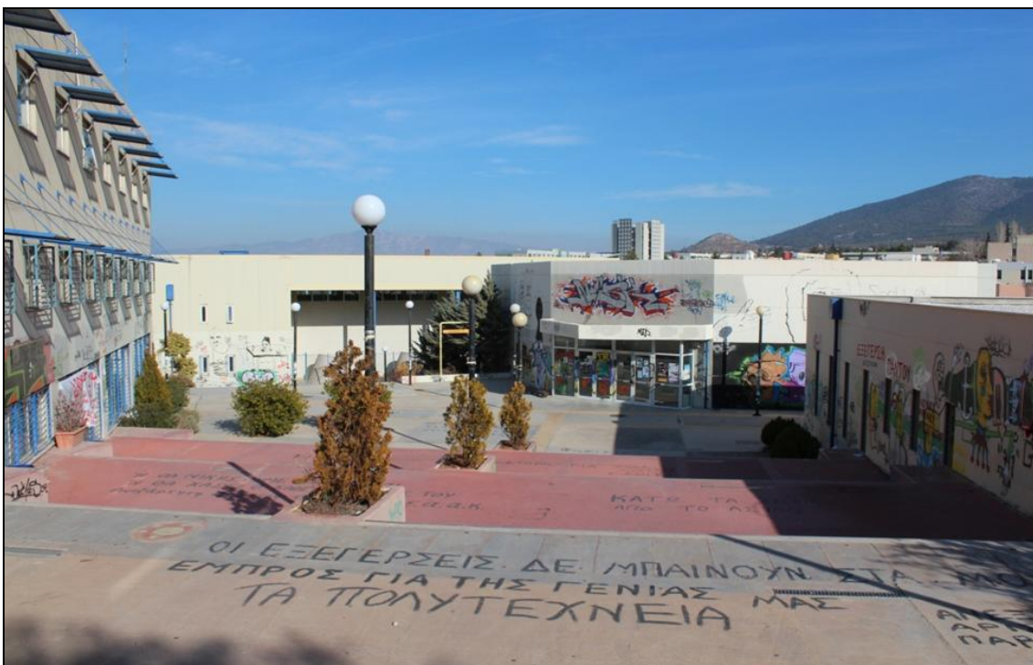
Εικόνα 5.57. Πολιτικοί Μηχανικοί (νέα κτίρια). Μικρά κηπάρια, σε εκτεταμένες σκληρές επιφάνειες. Απουσία καθιστικών και κατασκευών για σκίαση
