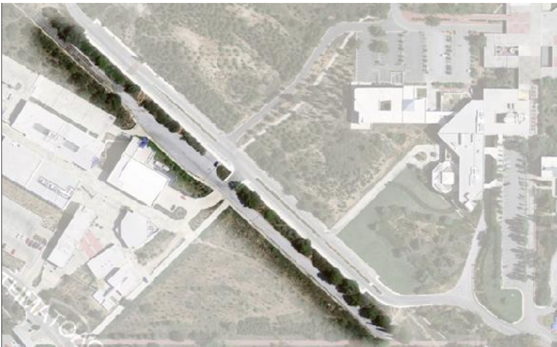
Εικ. 5.51. Διακρίνεται μία διαμπερή οδός που εξυπηρετεί σε μικρό βαθμό την κίνηση οχημάτων, καθώς και εναπομείναντα τμήματα οδοστρώματος από κατάργηση δρόμου που καταλήγουν στον κεντρικό πεζόδρομο και στις σιδηροδρομικές ράγες
