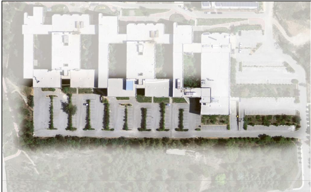
Εικόνα 5.44. Χώρος στάθμευσης Μεταλλειολόγων και Ηλεκτρολόγων. έλλειψη διακριτών εισόδου και εξόδου οχημάτων, κατακερματισμός σε επιμέρους τμήματα που δεν είναι συνδεδεμένα, στενές νησίδες που δυσχεραίνουν τους ελιγμούς
