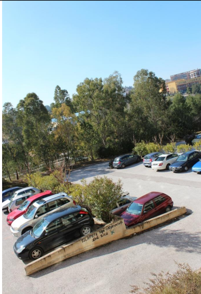
Εικόνα 5.43. Χώρος στάθμευσης Μεταλλειολόγων και Ηλεκτρολόγων. Οι μεγάλες κλίσεις του οδοστρώματος, το μήκος θέσης στάθμευσης (4,20 m) και τα τοιχεία αντιστήριξης αντί για κατάλληλα διαμορφωμένες νησίδες (πλάτος, ακτίνα στροφής) δυσχεραίνουν την κίνηση και τους ελιγμούς των οχημάτων.
