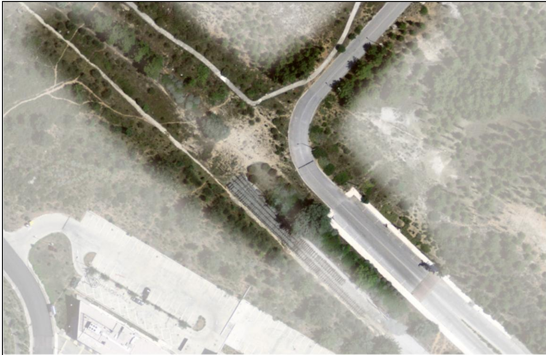
Εικόνα 5.17. Μεταξύ των μεγάλου πλάτους πεζοδρομίων και των δευτερευόντων πεζόδρομων υπάρχει κενό και έλλειψη σύνδεσης. Η αποσπασματικότητα και έλλειψη σύνδεσης οφείλεται σε κατάργηση δρόμου που δεν συνοδεύτηκε από εφαρμογή ολοκληρωμένου σχεδιασμού
