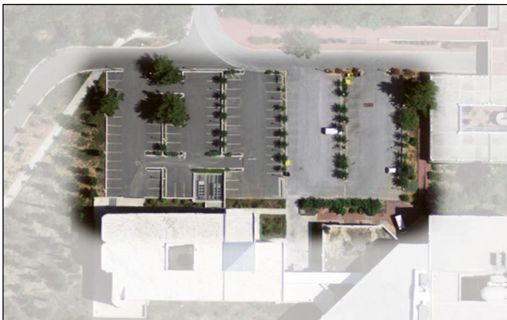
Εικ. 5.45. Χώρος στάθμευσης κτήριο Διεύθυνσης Οικονομικών Υπηρεσιών της Κεντρικής Διοίκησης Μεταλλειολόγων και Ηλεκτρολόγων. Μη οριοθέτηση με σαφήνεια κύριας εισόδου και εξόδου οχημάτων, κατακερματισμός σε επιμέρους τμήματα που δεν είναι συνδεδεμένα, στενές νησίδες που δυσχεραίνουν τους ελιγμούς
