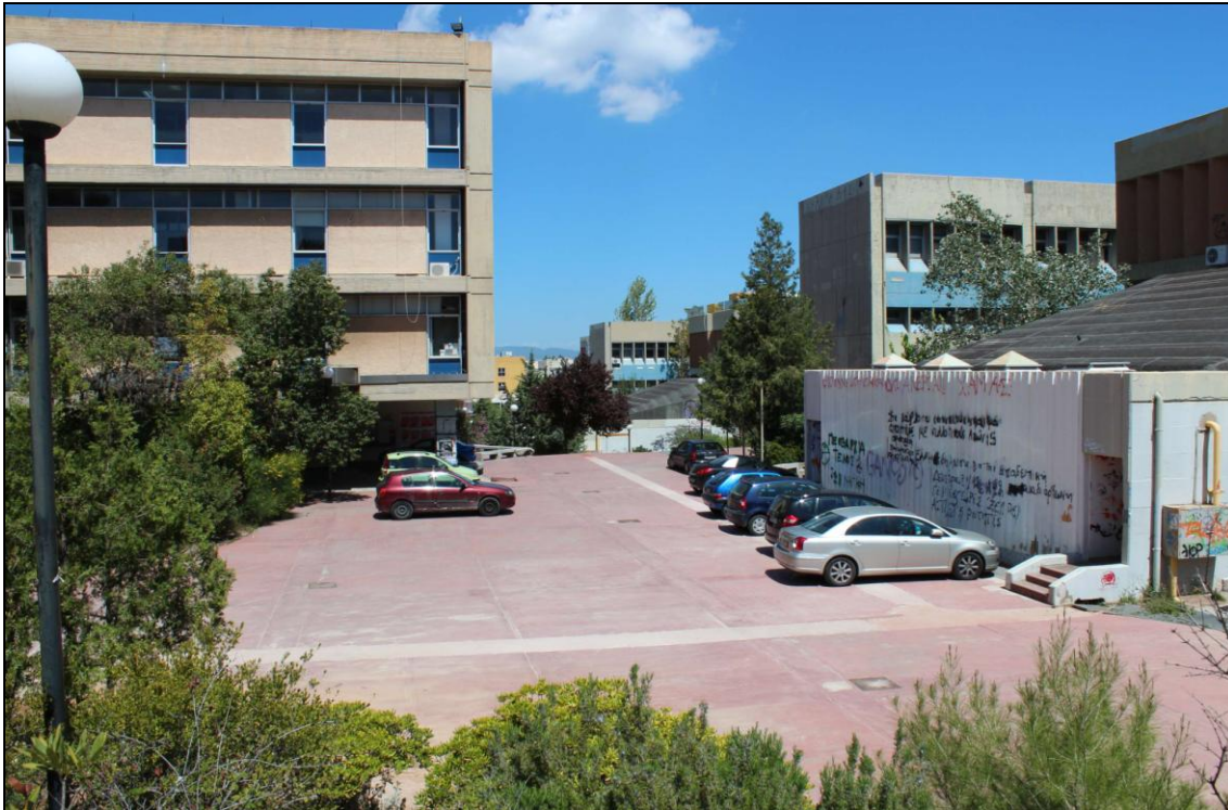
Εικόνα 5.60. Πλατείες μεταξύ ΣΕΜΦΕ και Χημικών Μηχανικών. Οι εκτεταμένες σκληρές επιφάνειες χωρίς διαμόρφωση ως ολοκληρωμένος χώρος συνάθροισης με κήπους και καθιστικά έχει συμβάλει και στην αυθαίρετη στάθμευση.
