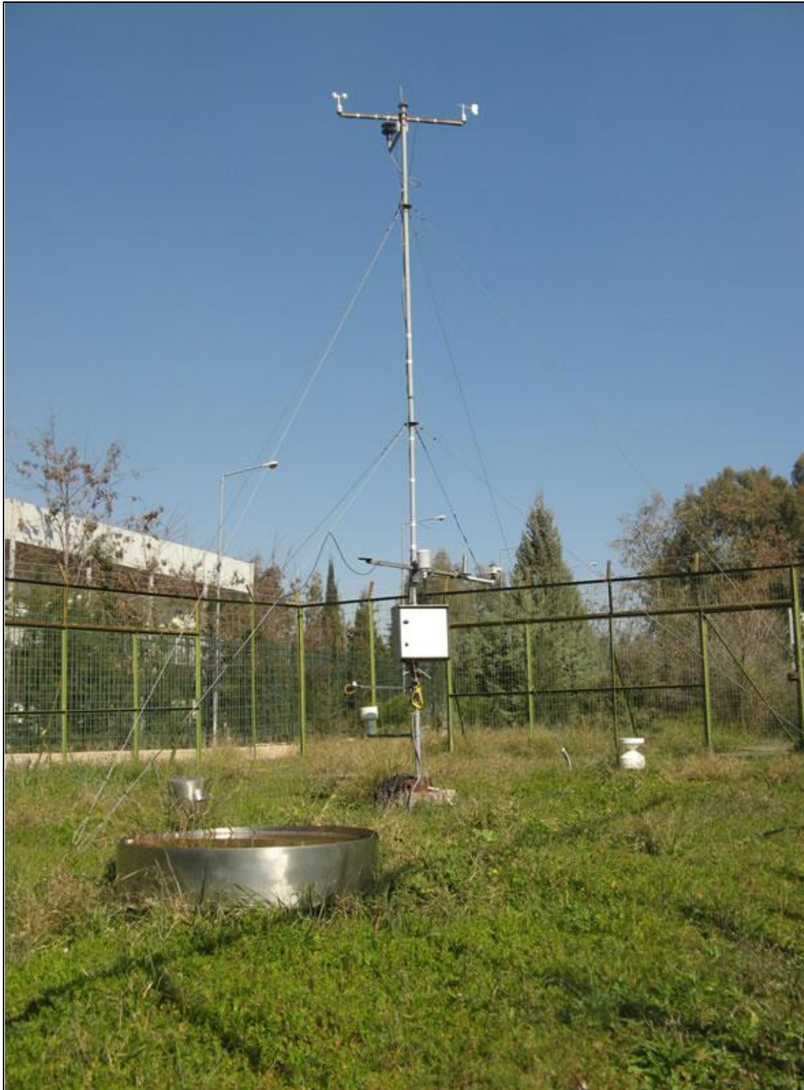
Εικόνα 3.2. Υδρολογικός και Μετεωρολογικός σταθμός στην Πολυτεχνειούπολη Ζωγράφου.
