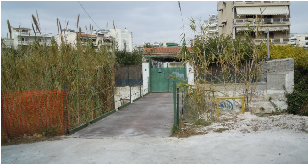
Εικ.39 Ιδιωτική πεζογέφυρα
