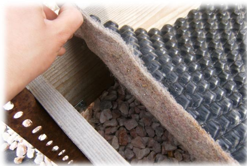
Εικόνα 2.1 Η διαμόρφωση του βάθους πραγματοποιήθηκε με την τοποθέτηση γαρμπιλιού.
