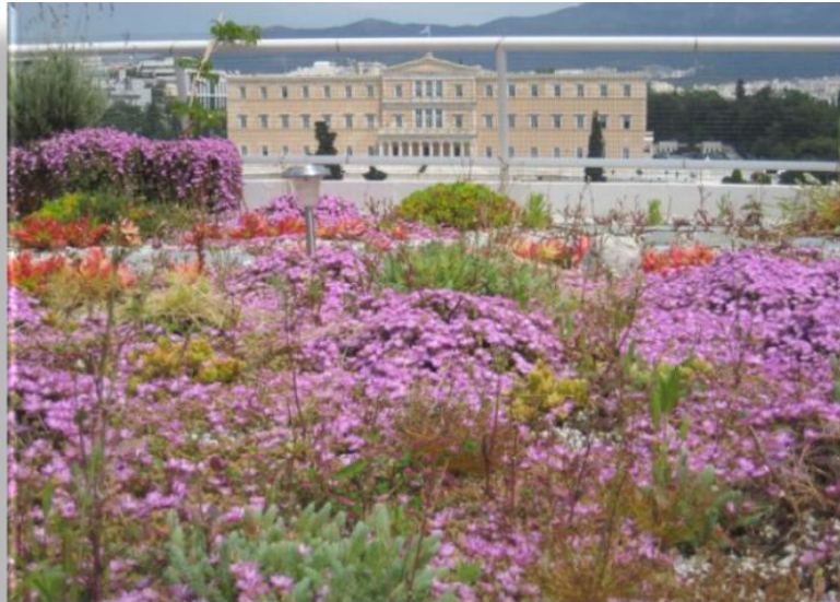
Εικόνα 1.4 Η οροφή του κτηρίου του Υπουργείου οικονομικών στην οποία έχει εφαρμοστεί εκτατικό φυτοδώμα ( http://www.petridislandscape.gr/steges.html )
