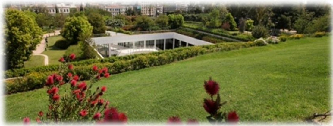
Εικόνα 1.2 Εντατικός τύπος φυτεμένου δώματος στον κήπο του Μεγάρου Μουσικής Αθηνών (πηγή: http://www.megaron.gr/default.asp?pid=109&la=1 )
