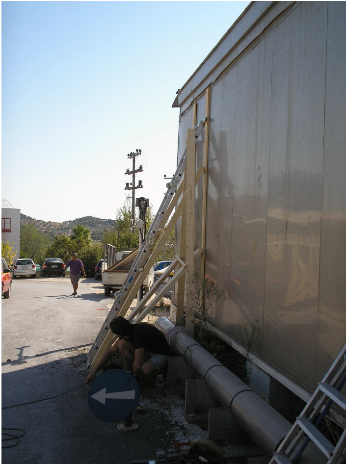
Εικόνα Π1. Εξωτερική Επισκευή του Test Cell στο ΚΑΠΕ
