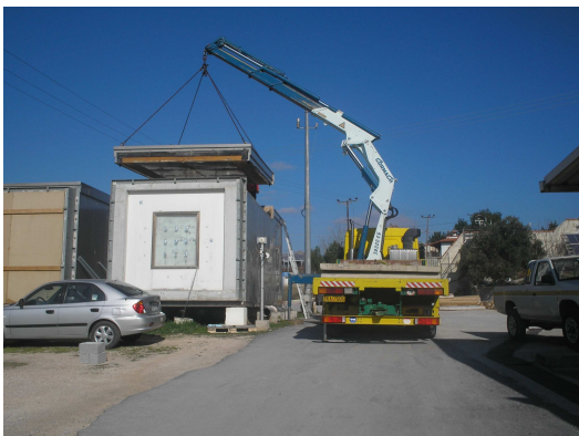
Εικόνα Π3α. Αφαίρεση της μετακινούμενης οροφής του θαλάμου test cell.
