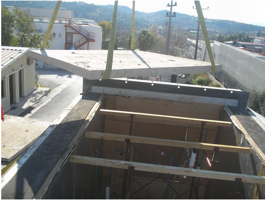
Εικόνα 7.6. Τοποθέτηση πλάκας σκυροδέματος πάχους 12 cm, ως οροφή του θαλάμου δοκιμών, επί του κατάλληλου ξυλότυπου. Λήψη 12/01/2008.
