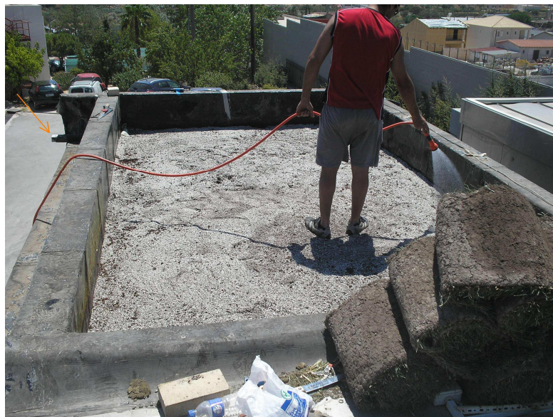
Εικόνα 7.3. Εγκατάσταση δεύτερου δοκιμίου επί της οροφής του Θαλάμου δοκιμών στο ΚΑΠΕ, με υπόστρωμα μίγμα κίσηρης, τύρφης και ζεόλιθου και φύτευση πάλι από χλοοτάπητα αποτελούμενου από μίγμα ποικιλιών Festuca arundinacea . Με βέλος σημειώνεται το κανάλι απορροής των στραγγισμάτων.
