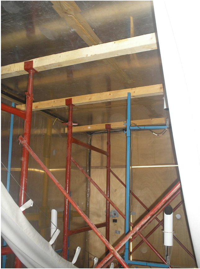
Εικόνα Π2. Εσωτερική στήριξη με ξυλότυπο, για την υποδοχή της πλάκας οροφής στο Test Cell. Διακρίνονται οι επί ορθοστάτη αναρτημένοι, αισθητήρες θερμοκρασίας αέρα, θαλάμου δοκιμών.
