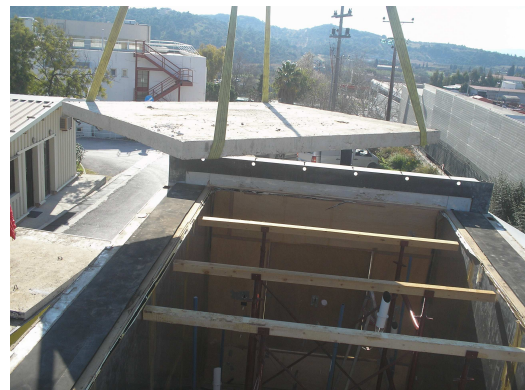
Εικόνα Π4β. Τοποθέτηση έτοιμης πλάκας σκυροδέματος.
