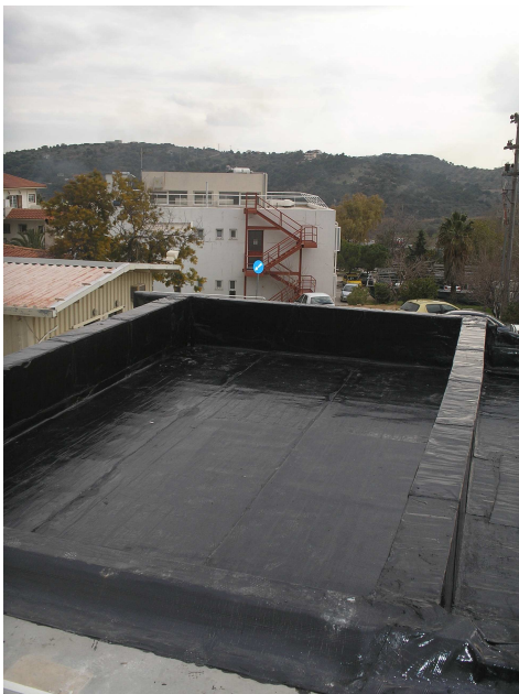
Εικόνα Π6. Στεγανοποίηση του δώματος με αντιριζική ασφαλτική μεμβράνη.
