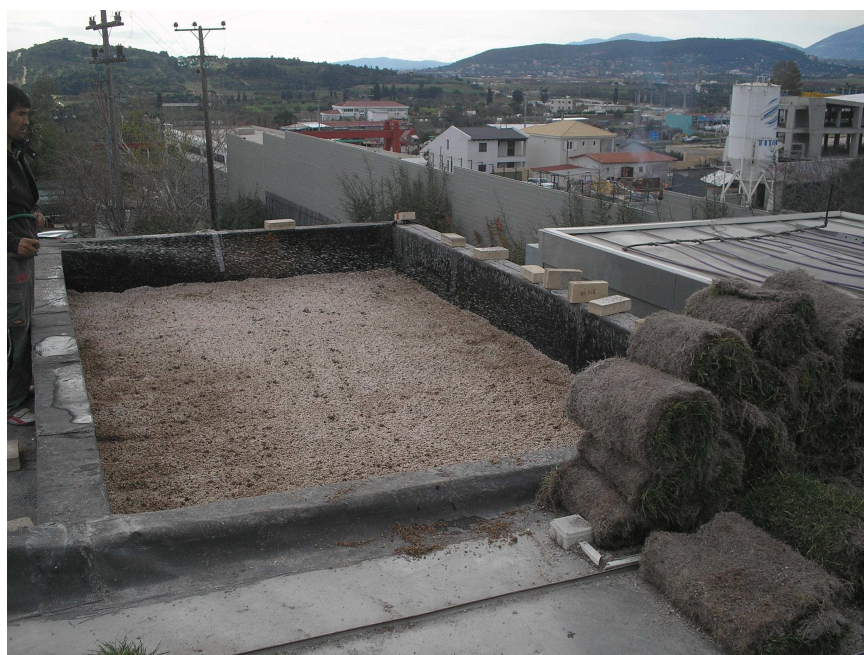
Εικόνα 7.4. Εγκατάσταση του τρίτου δοκιμίου φυτεμένου δώματος επί της οροφής του Θαλάμου δοκιμών στο ΚΑΠΕ, με υπόστρωμα μίγμα περλίτη, εδάφους και ζεόλιθου και φύτευση έτοιμου χλοοτάπητα αποτελούμενου από ποικιλίες του είδους Festuca arundinacea .
