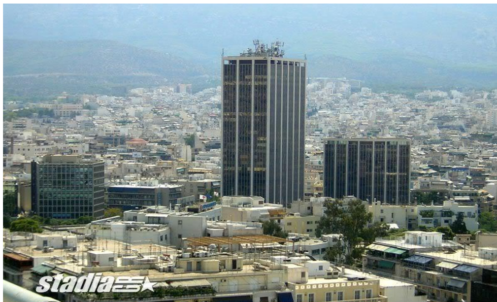
Εικόνα 5 : Πυκνή δόμηση και ψηλά κτίρια στο κέντρο της Αθήνας
