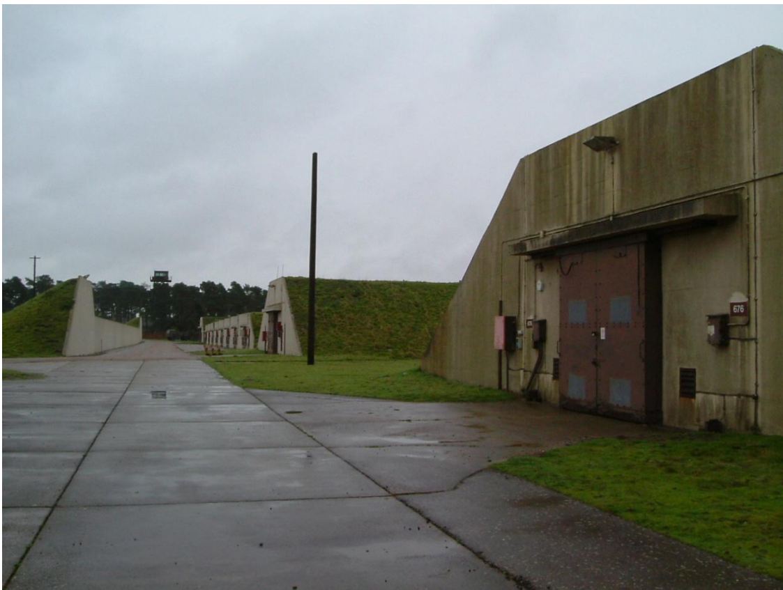
Εικόνα 23. Υποδομές που έχουν διατηρηθεί στο πρώην αεροδρόμιο - Αποθήκες βομβών (Πηγή: http://www.oceanskypictures.com/images/botw_locations/stores_5.JPG )
