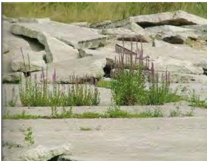
Εικόνα 21. Αεροδρόμιο Maurice Rose . Θραύση σκληρών επιφανειών και φύτευση στα κενά (Πηγή: http://3.bp.blogspot.com/_Zb_A2nLRnfA/RokkxRjOS_I/AAAAAAAAAeM/JLlSkx0uVni/s400/DSCN4232.JPG )
