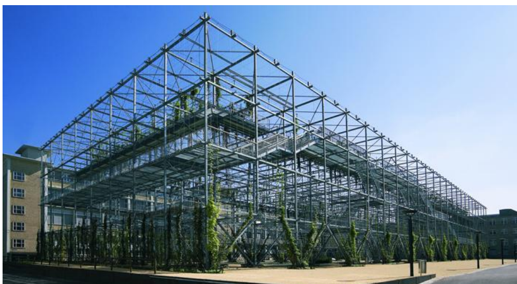
Εικόνα 91. MFO park Ζυρίχης -Το πάρκο – μεταλλικό πλέγμα αναρριχώμενων φυτών πριν προλάβει να σχηματίσει τα «φυτικά του τείχη» (Πηγή: http://www.burckhardtpartner.ch/projectimages/mfo/bild5.jpg/image ).
