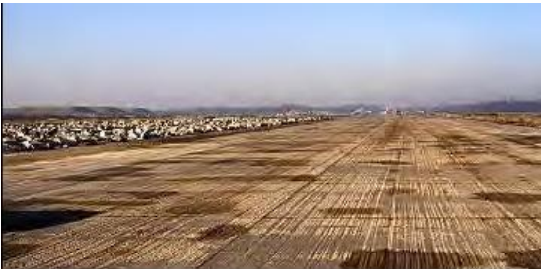
Εικόνα 13. Αεροδρόμιο Greenham Common . Απορρύπανση και αποξήλωση διαδρόμου προσγείωσης (Πηγή: http://www.sustainable-greenham.org/sec-act07.php )
