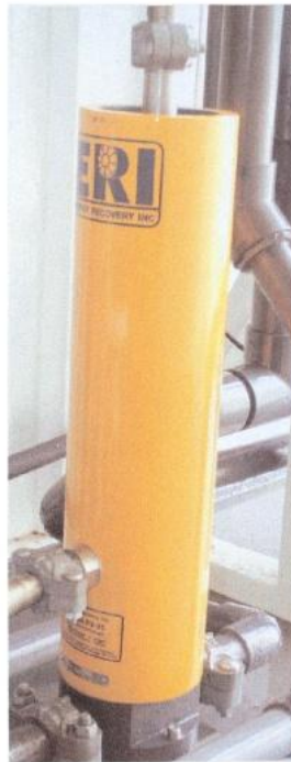
Εικόνα 1-10: Ανακτητής ενέργειας τύπου (PX)
