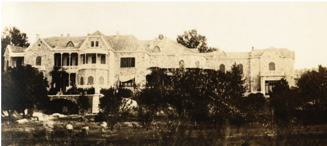
ΕΙΚΟΝΑ 7 : Το νέο ανάκτορο κατά το έτος 1888/1890. Διακρίνεται ο υπό διαμόρφωση κήπος (πηγή: Σταματόπουλος, 2004)
