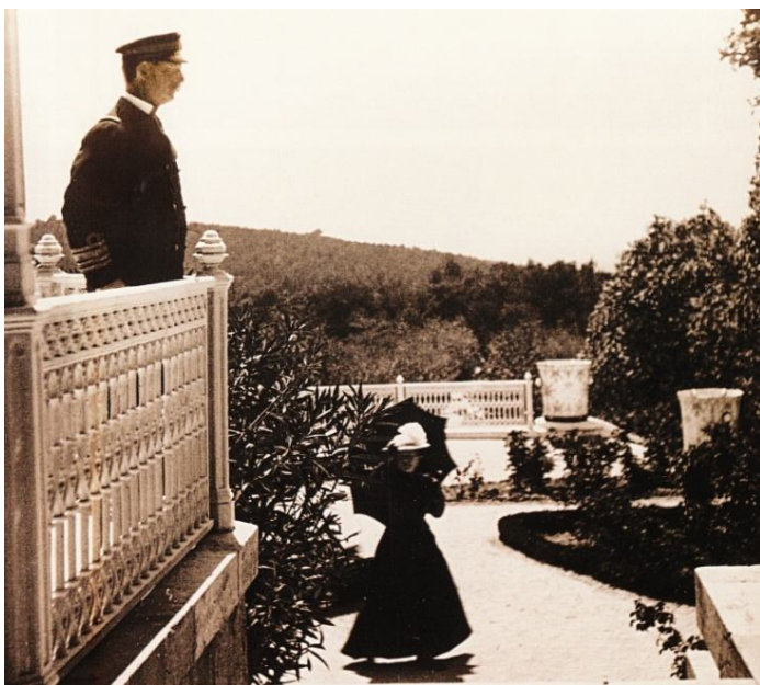
ΕΙΚΟΝΑ 94: Άποψη του άνδριου στη νότια πλευρά του κτιρίου. Διακρίνονται τα διαμορφωμένα παρτέρια και τα μεγάλα μεταλλικά φυτοδοχεία στην κορυφή της κλίμακας (πηγή: Σταματόπουλος, 2004)
