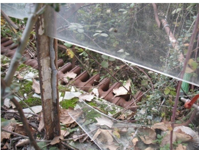
ΕΙΚΟΝΑ 58: Θερμαντικό σώμα στο εσωτερικό του θερμοκηπίου
