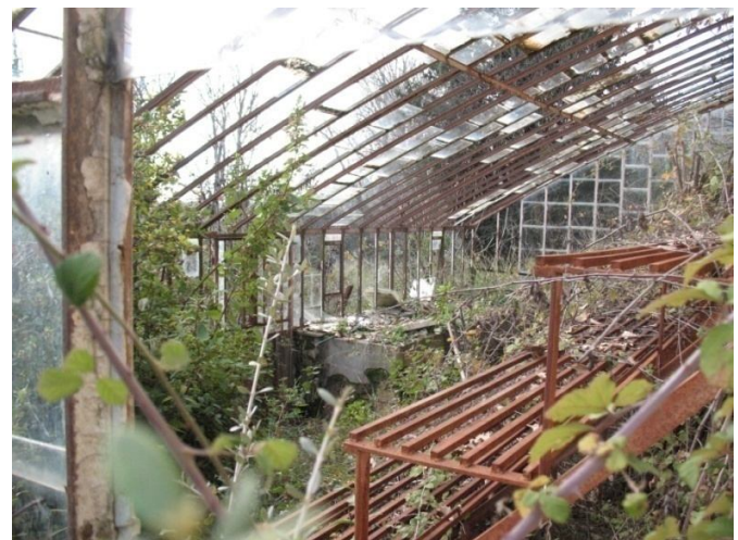
ΕΙΚΟΝΑ 57: Το θερμοκήπιο (άποψη του εσωτερικού)
