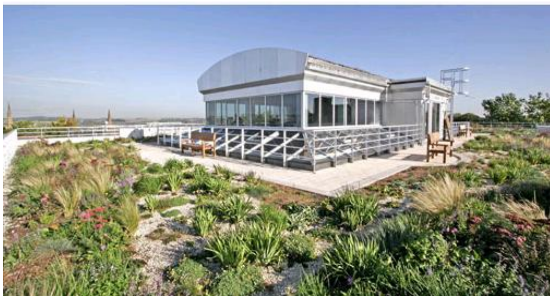
Εικόνα 8. Φυτεμένο δώμα ημι-εντατικού τύπου στην Μεγάλη Βρετανία. (Πηγή: http:// www.zinco-greenroof.com )
