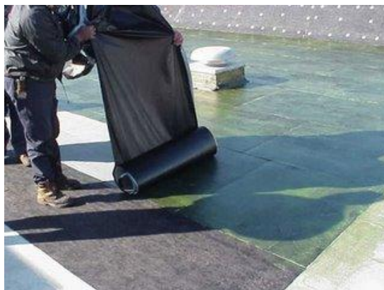
Εικόνα 13. Μεμβράνη PVC για στεγανοποιήσεις ταρατσών με αντιριζική αντοχή βάση της διεθνούς απαίτησης FLL. (Πηγή: http:// www.renovat.gr )
