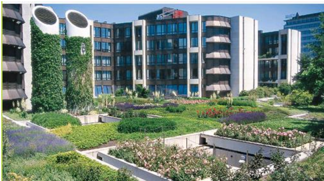
Εικόνα 9. Φυτεμένο δώμα εντατικού τύπου στην Βασιλεία, Ελβετία. (Πηγή: http://www.zinco-greenroof.com )
