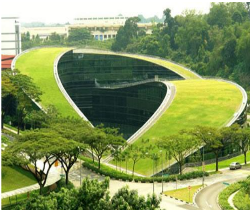
Εικόνα7. Φυτεμένο δώμα εκτατικού τύπου στην Σιγκαπούρη (School of Art and Design) (Πηγή: http://www. greenroofs.com )
