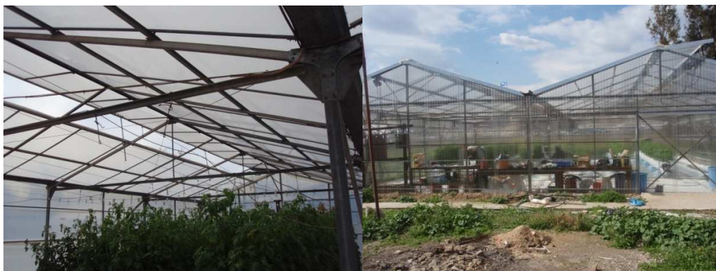
Εικόνα 1-2: Εσωτερική και εξωτερική όψη του θερμοκηπίου
