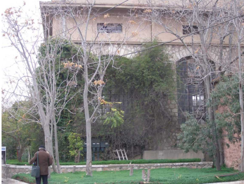
Εικόνα 35: Άποψη από Βιομηχανικό κτίριο Α' ( http://courses.arch.ntua.gr/106340.html )
