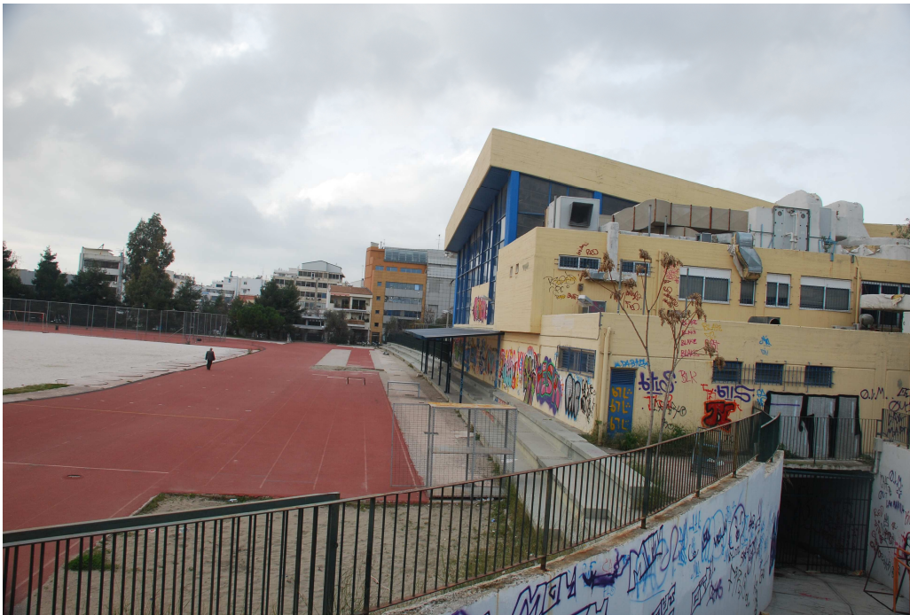
Εικόνα 19: Οι εγκαταστάσεις του Τμήματος Επιστήμης Φυσικής Αγωγής και Αθλητισμού στην Λεωφόρο Ηλιουπόλεως, απέναντι από την ΠΥΡΚΑΛ (πηγή: Βίκτωρας Θωμόπουλος)
