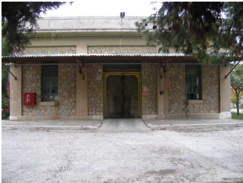
Εικόνα 46: Άποψη από το Τμήμα Νέας Καλυκοποιείας ( http://courses.arch.ntua.gr/106340.html )
