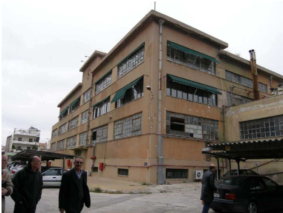
Εικόνα 25: Άποψη από το κτίριο του Οβιδουργείου
