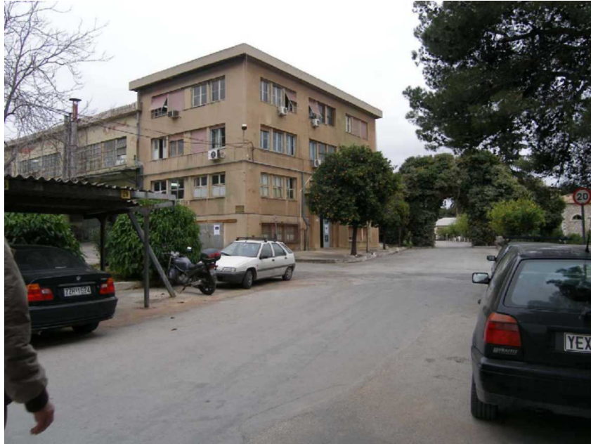
Εικόνα 29: Άποψη από το κτίριο ΙΝΤΕΞ ( http://courses.arch.ntua.gr/106340.html )
