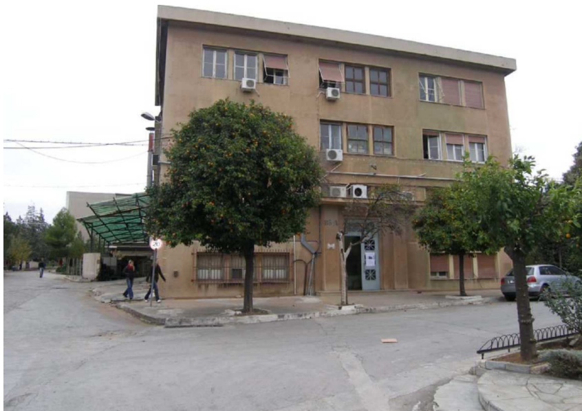
Εικόνα 30: Άποψη από το κτίριο ΙΝΤΕΞ ( http://courses.arch.ntua.gr/106340.html )
