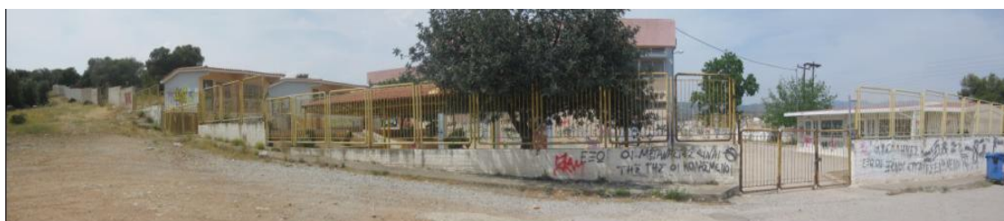
Εικ. 47: Περιφραξη σχιλοκού κτιρίου (σιδερένια κάγκελα – τσιμεντόλιθους)
