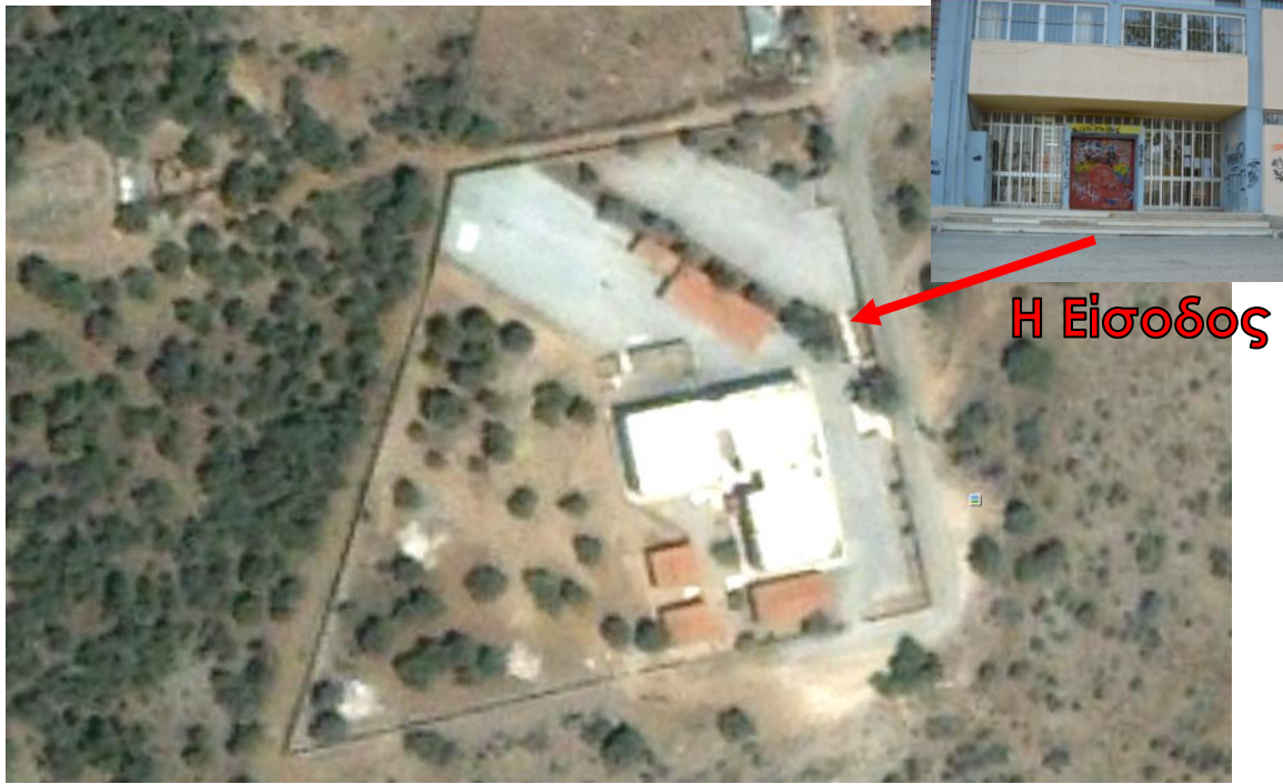
Εικ. 43: Είσοδος σχολείου από την ανατολική πλευρά
