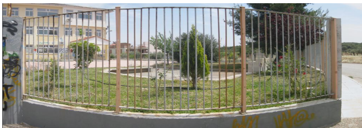
Εικ. 58: Απεικονήσεις από την δυτική πλευρά του σχολικού κτιρίου
