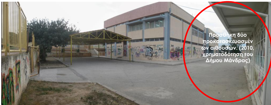
Εικ. 44: Νότια πλευρά σχολείου, στέγαστρο με κεραμοσκεπή
