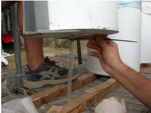
Εικόνα 6. Τοποθέτηση και σταθεροποίηση του εύκαμπτου, διάφανου σωλήνα στην άκρη των σπειρωμάτων. Πηγή: Τσογγαράκης, 2005; Κοτοπούλης 2006
