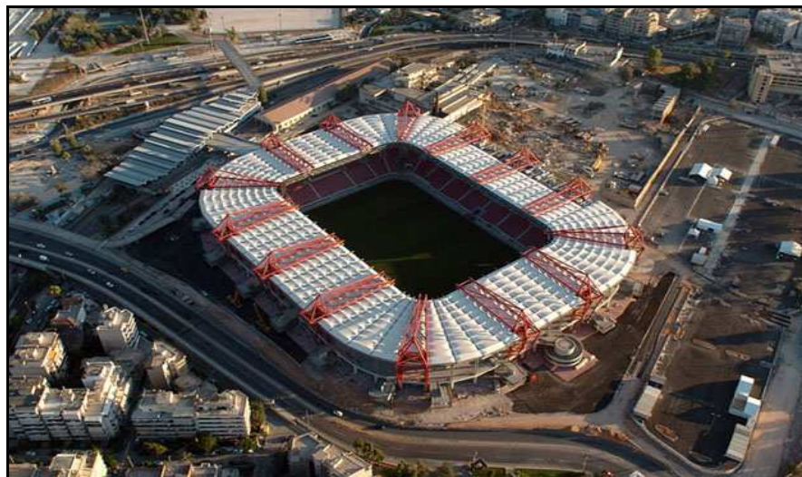
Εικόνα 8.15. Το νέο γήπεδο Γεώργιος Καραϊσκάκης μετά την κατασκευή του το 2004 (Πηγή: http://img9.imageshack.us/img9/2129/karaiskaki24th.jpg )
