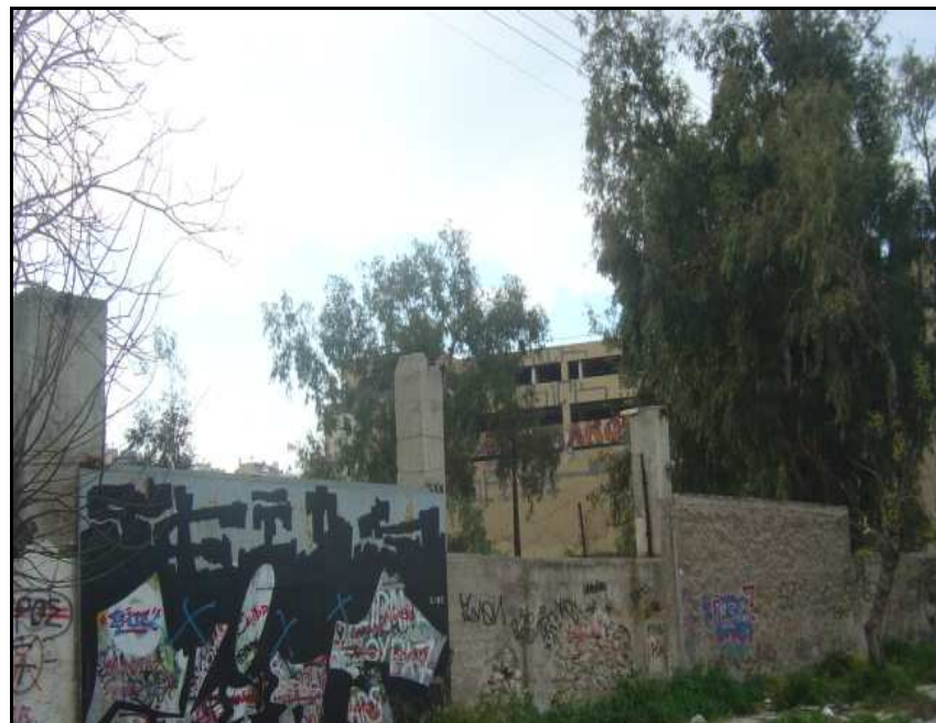
Εικόνα 8.31. Άποψη του ακάλυπτου χώρου από την οδό Κατσουλάκου (Πηγή : Αρμπής Γεώργιος)
