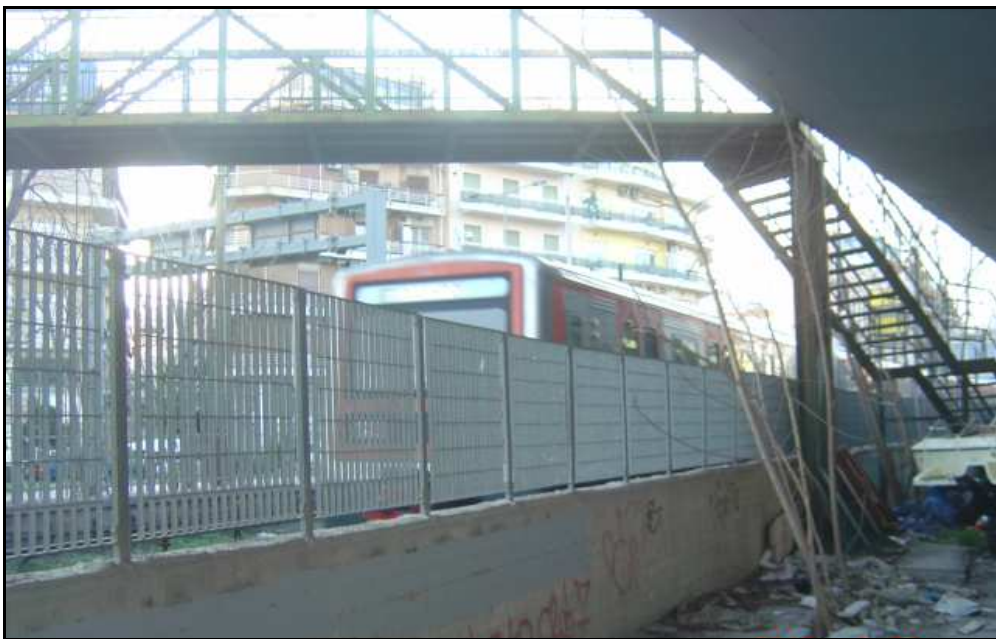
Εικόνα 9.10. Άποψη του ηλεκτρικού σιδηρόδρομου κάτω από την υπερυψωμένη λεωφόρο Μικράς Ασίας (Πηγή: Αρμπής Γεώργιος)
