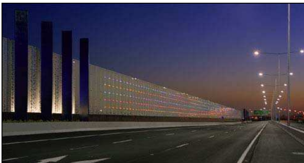
Εικόνα 5.2. Πρωτότυπη κατασκευή φωτισμένου ηχοπετάσματος (Πηγή : www.designshrine.net )
