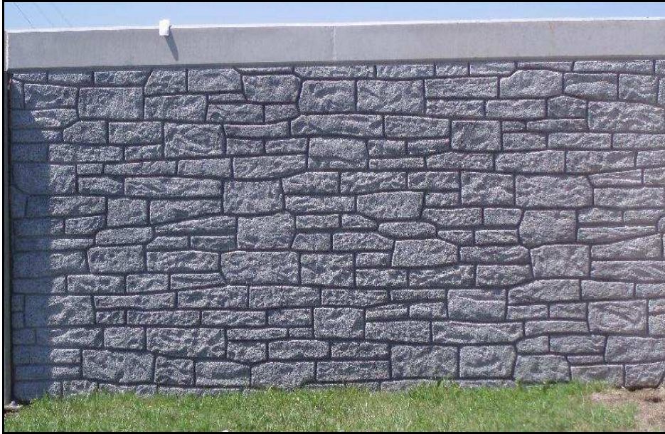
Εικόνα 11.1. Προτεινόμενο ηχοπέτασμα από σκυρόδεμα (Πηγή : www.whisper-wall.com )
