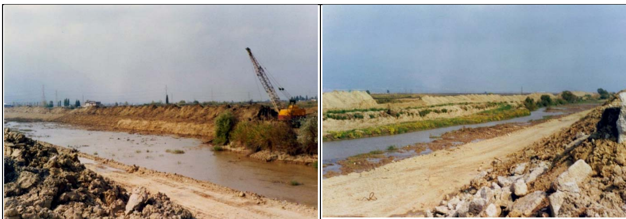
Εικόνα 2.2. Φωτογραφίες (1,2) που απεικονίζουν τα έργα διαπλάτυνσης που πραγματοποιήθηκαν στον Αγωγό Εκτροπής-Υπερχειλιστή του Σπερχειού ποταμού το 2001.
