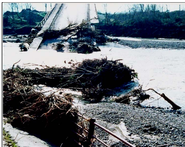
Εικόνα 2.17 α & β. Φωτογραφίες που απεικονίζουν την πολύ μεγάλη πλημμύρα που έγινε στην λεκάνη του Σπερχειού στις 14/01/1997 και η οποία κατέστρεψε εκτός των άλλων και 6 γέφυρες της περιοχής.
