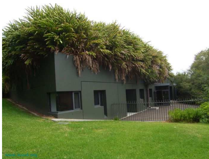
Εικόνα 14: Φυτοδώμα ημιεντατικού τύπου (Δ12)
