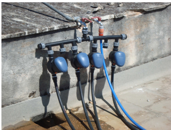
Εικόνα 25: Η παροχή νερού (βρύση της ταράτσας) και οι 4 ηλεκτροβάνες για τις διαφορετικές συχνότητες άρδευσης.
