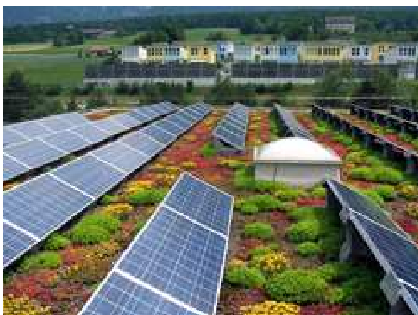
Εικόνα 15: Φυτοδώμα εκτατικού τύπου (Πηγή Δ12)
