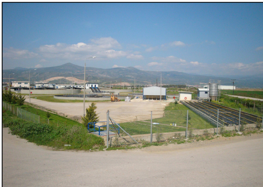
Εικόνα 11. Οι εγκαταστάσεις του βιολογικού καθαρισμού Λαμίας (Μάρτιος 2010). (Φωτογραφικό αρχείο – Κυροδήμος Η.).
