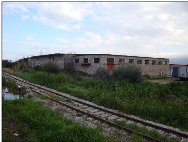
Εικόνα 21. Οι εγκαταστάσεις της Ένωσης Γεωργικών Συνεταιρισμών Λαμίας στη νότια πλευρά του στρατοπέδου (Νοέμβριος 2009). (Φωτογραφικό αρχείο – Κυροδήμος Η.).
